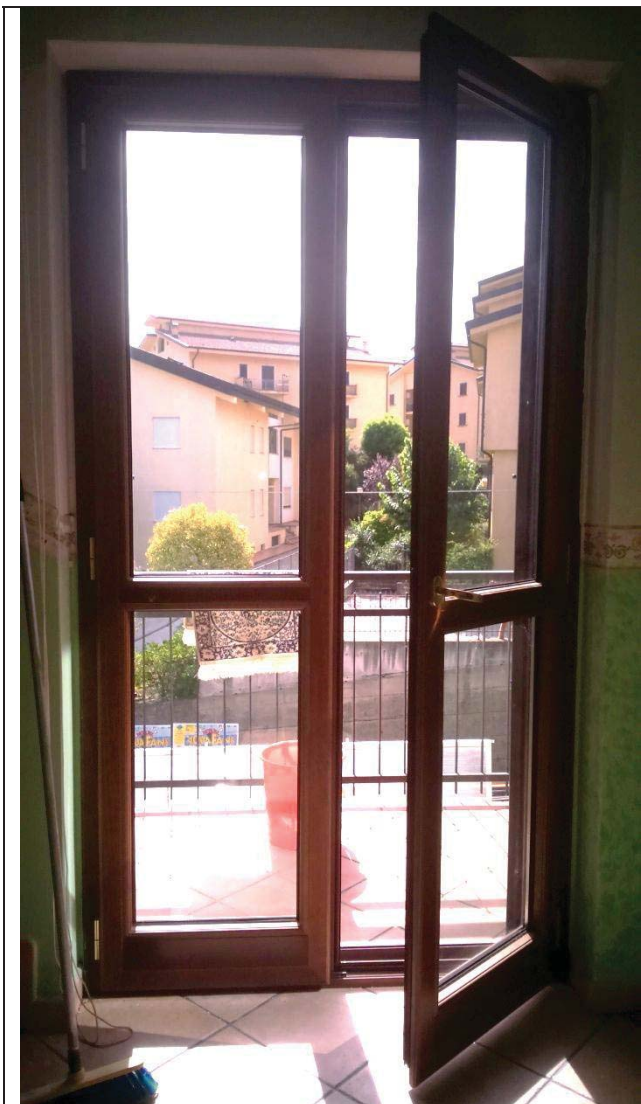
Balcone vano scala piano primo
