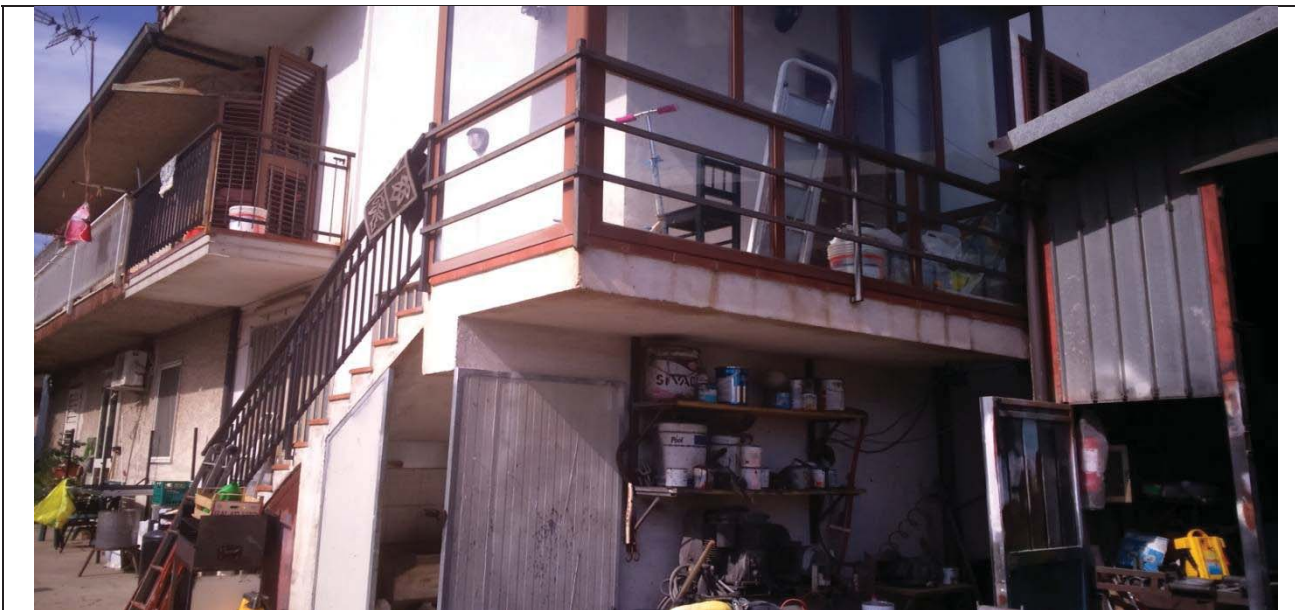
Scala di accesso
