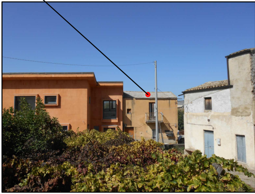
Copertura in Eternit
