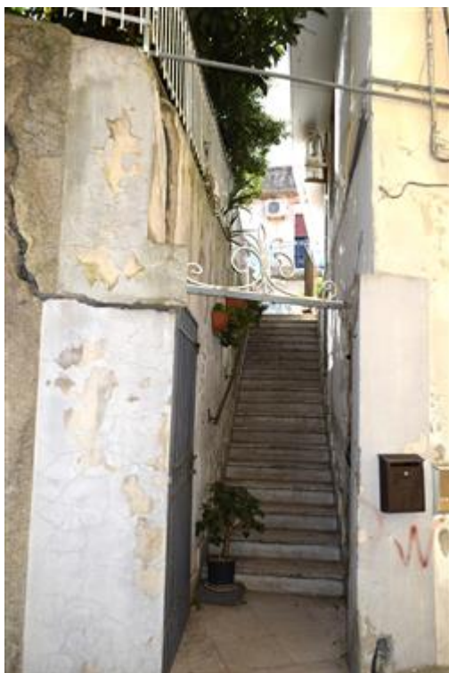
scala d'accesso al sub 4
