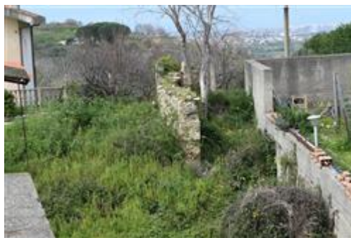
muro residuo del fabbricato
