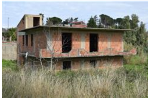
part 1577 vista dei prospetti sud e ovest visti dalla via Matteotti
