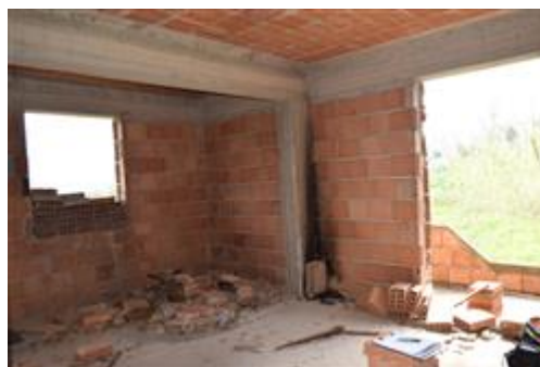
vano in cui la terrazza è stata annessa all'abitazione
