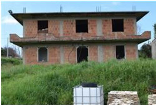
part 1577 prospetto est, al pt il deposito agricolo, al 1p appartamento e deposito agricolo
