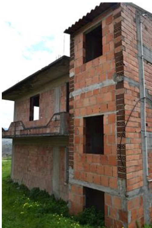
allp il deposito artigianale; vano scala chiuso in muratura
