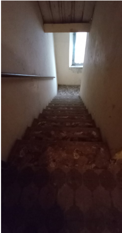
11 rampa scala comune
