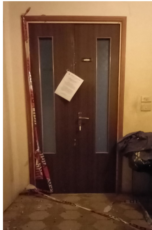
04 ingresso alloggio Piano Secondo
