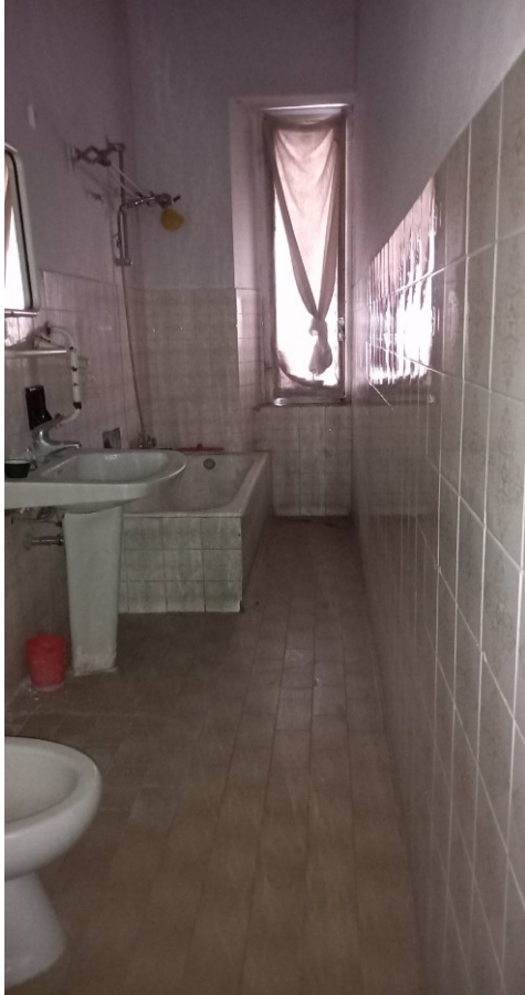
07 vista "A" del bagno
