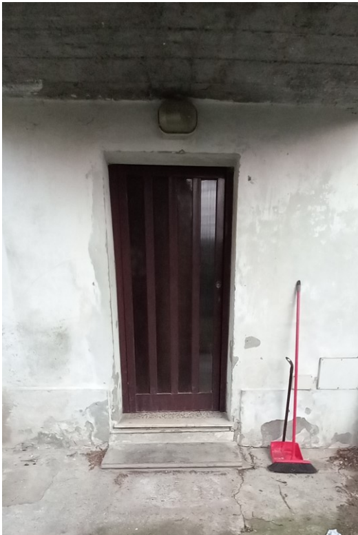
03 ingresso al vano scala dal cortile
