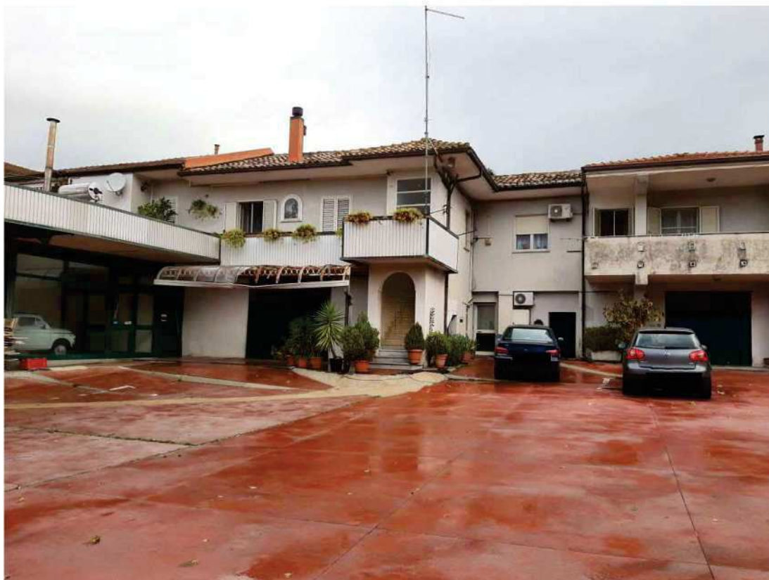
Prospetto Sud compendio
