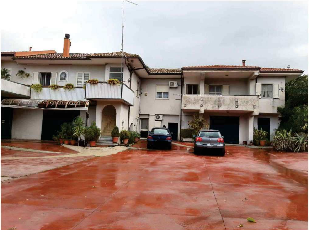
Prospetto Sud compendio
