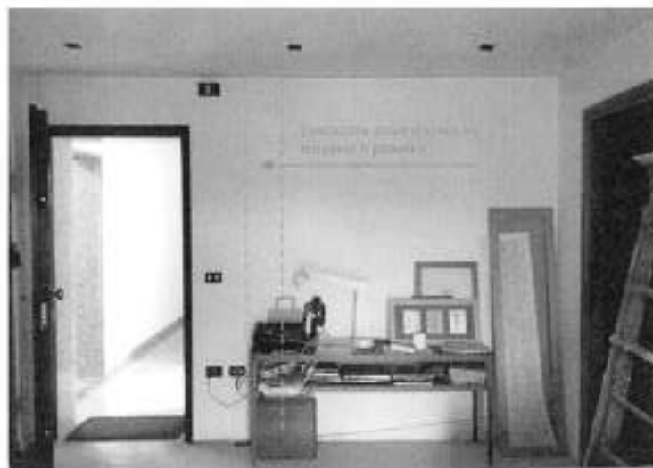
Figura 2: muro ingresso appartamento piano 3°
