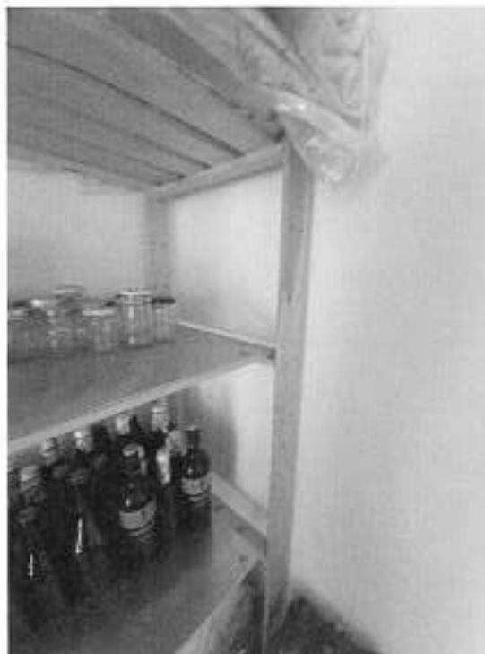
Figura 9: particolare muro vano ascensore
