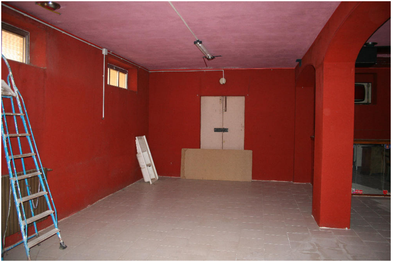
Vista del locale principale del deposito
