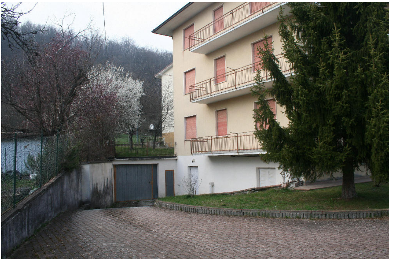
Vista del fabbricato dal giardino – particolare ingresso carraio alla parte comune dell'interrato
