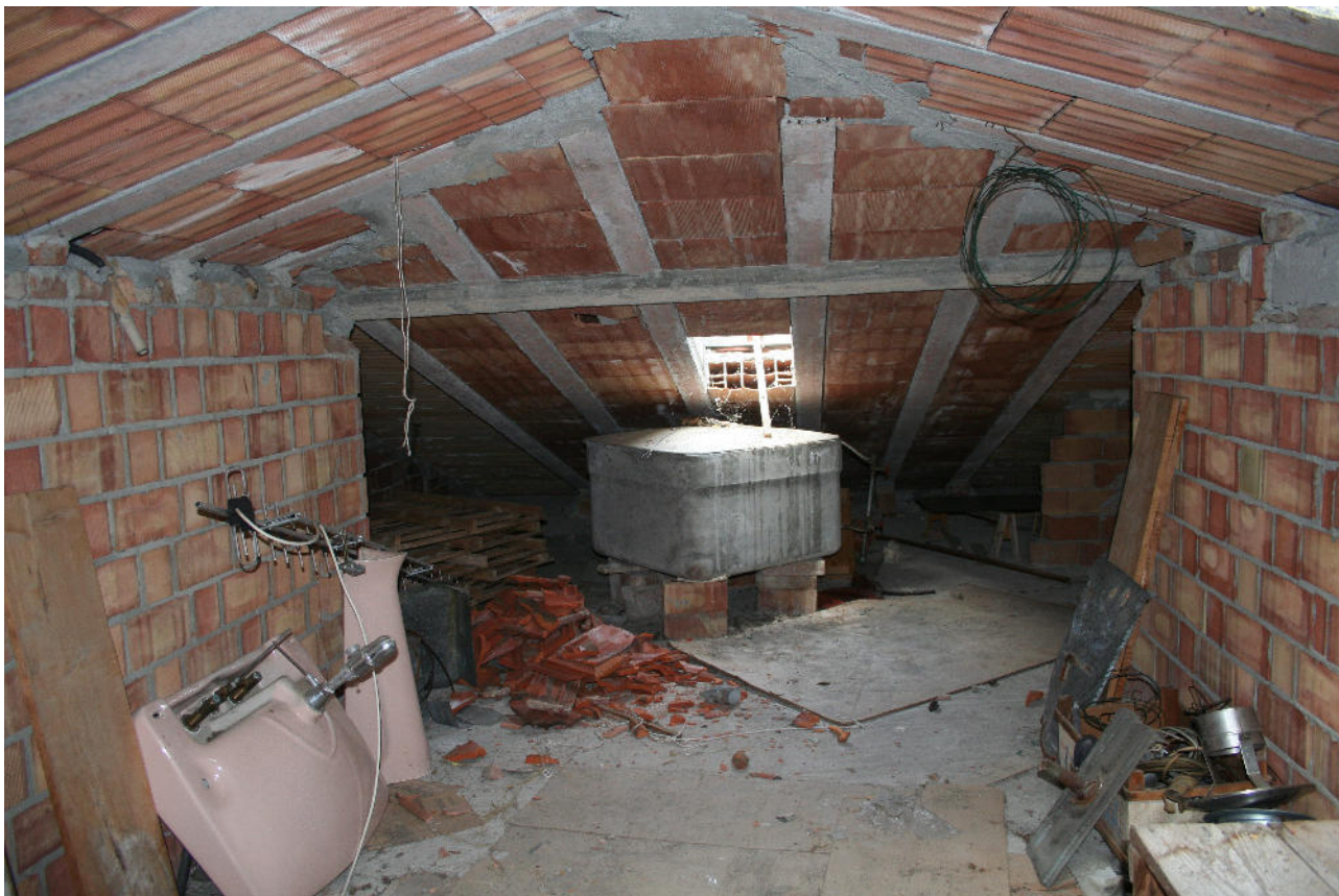
Vista del sottotetto comune agli appartamenti
