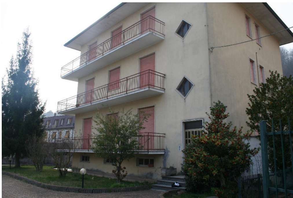
Vista del fabbricato – prospetto principale
