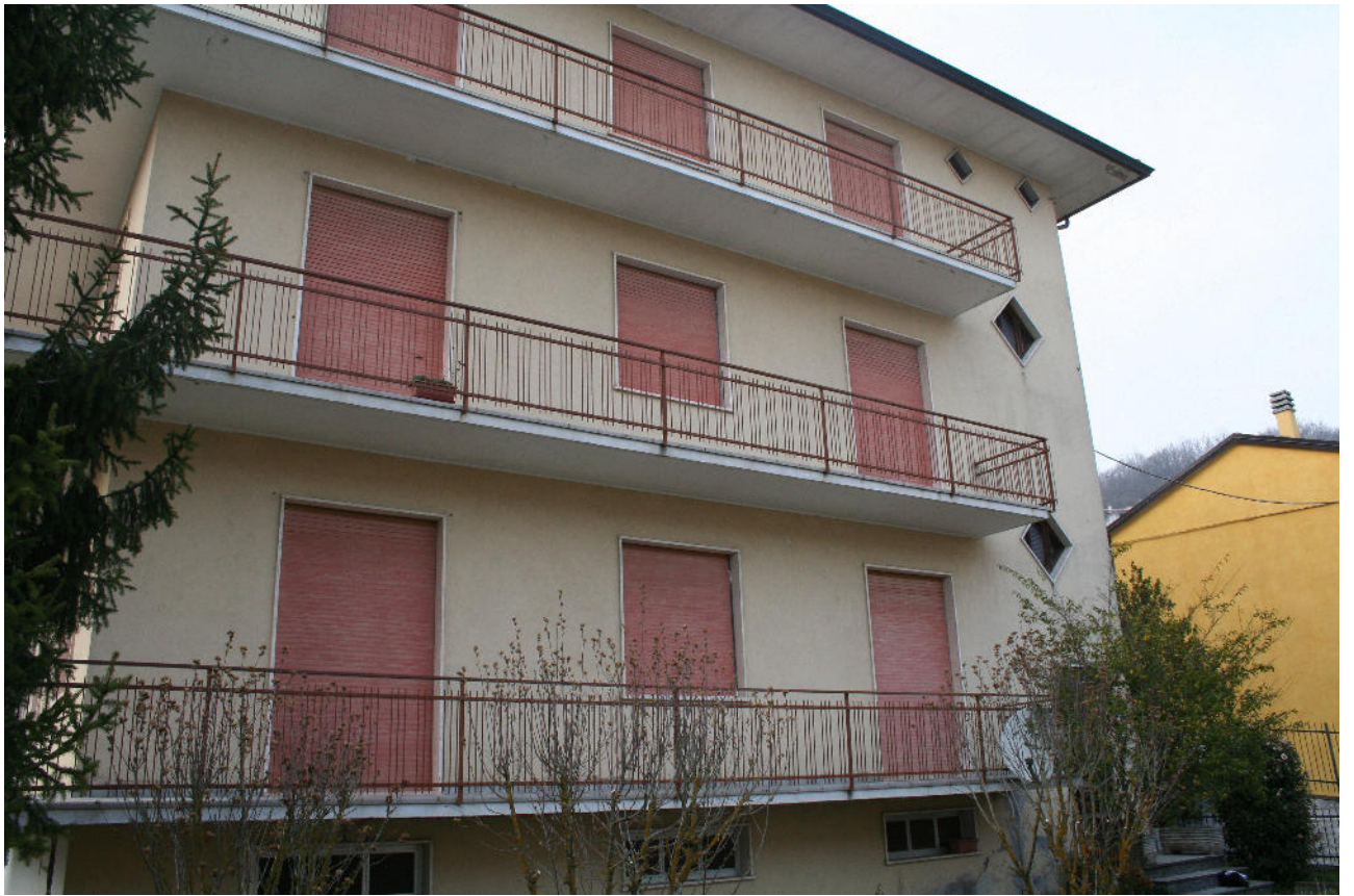
La facciata principale del fabbricato
