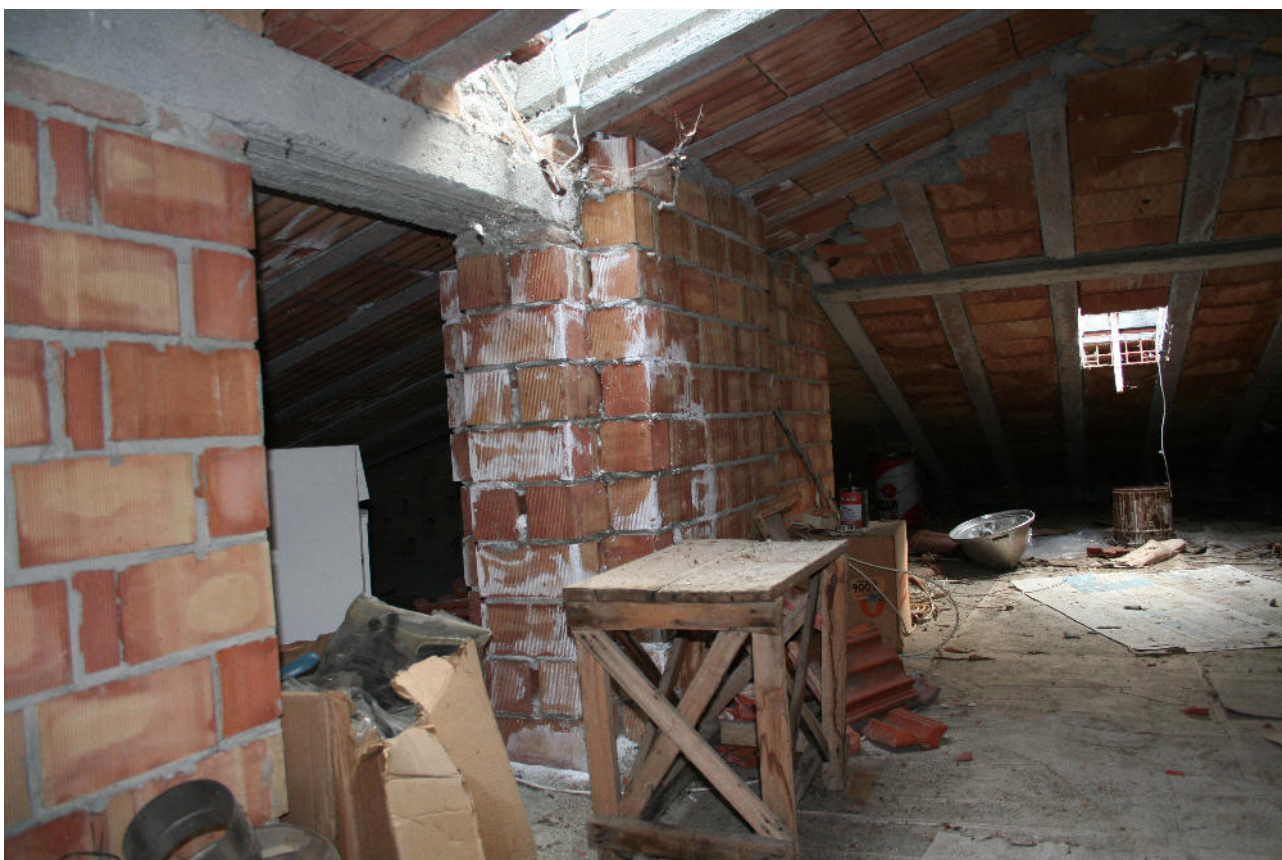
Vista del sottotetto comune agli appartamenti
