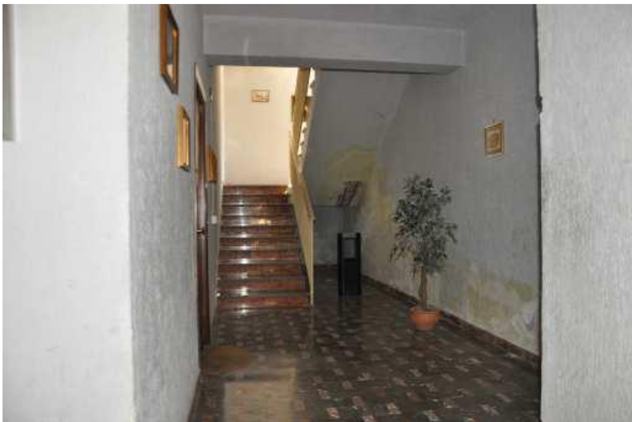
Foto 5 - Corpo scala condominiale
