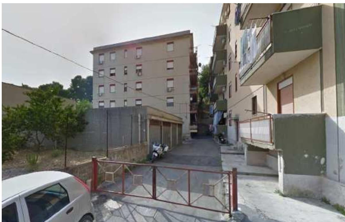
Foto 2 - L'unità edilizia - Prospetto ovest
