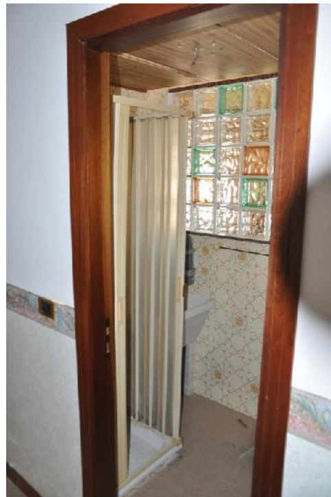
Foto 14 – Ripostiglio con doccia e lavatoio
