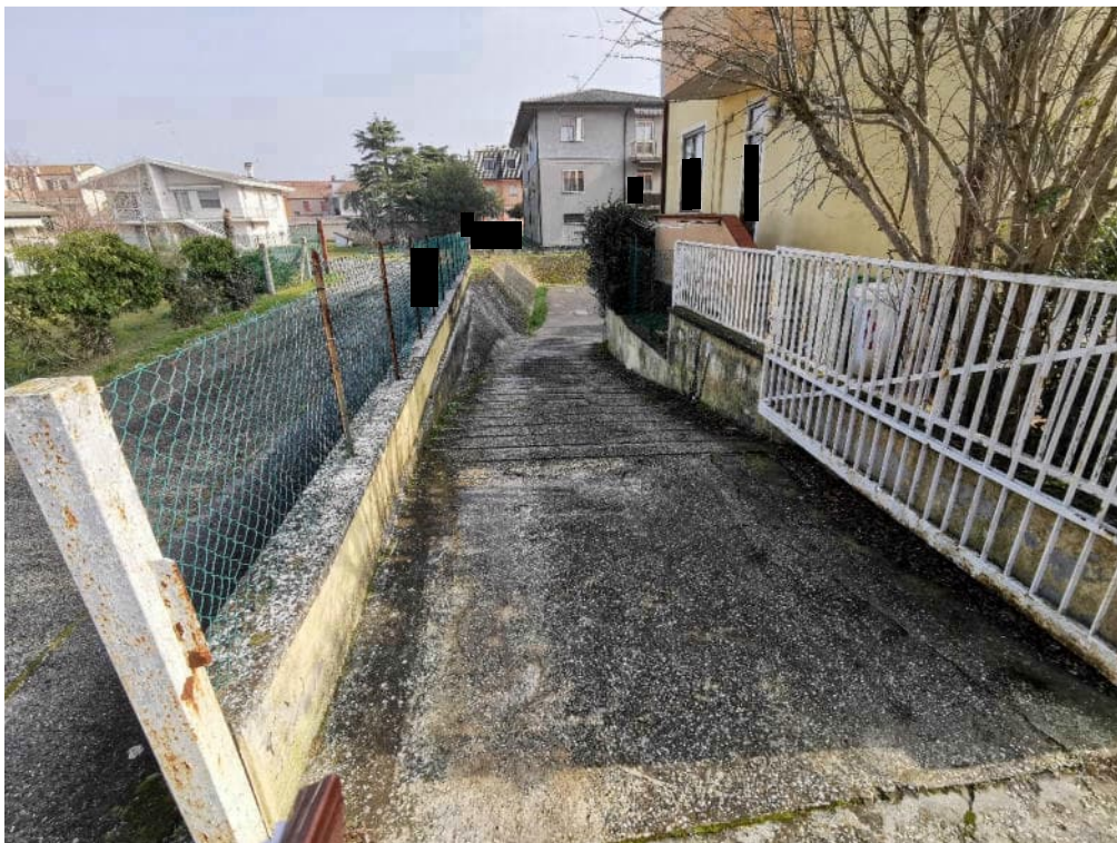
FOTOGRAFIA N. 8 -rampa di accesso ai garage
