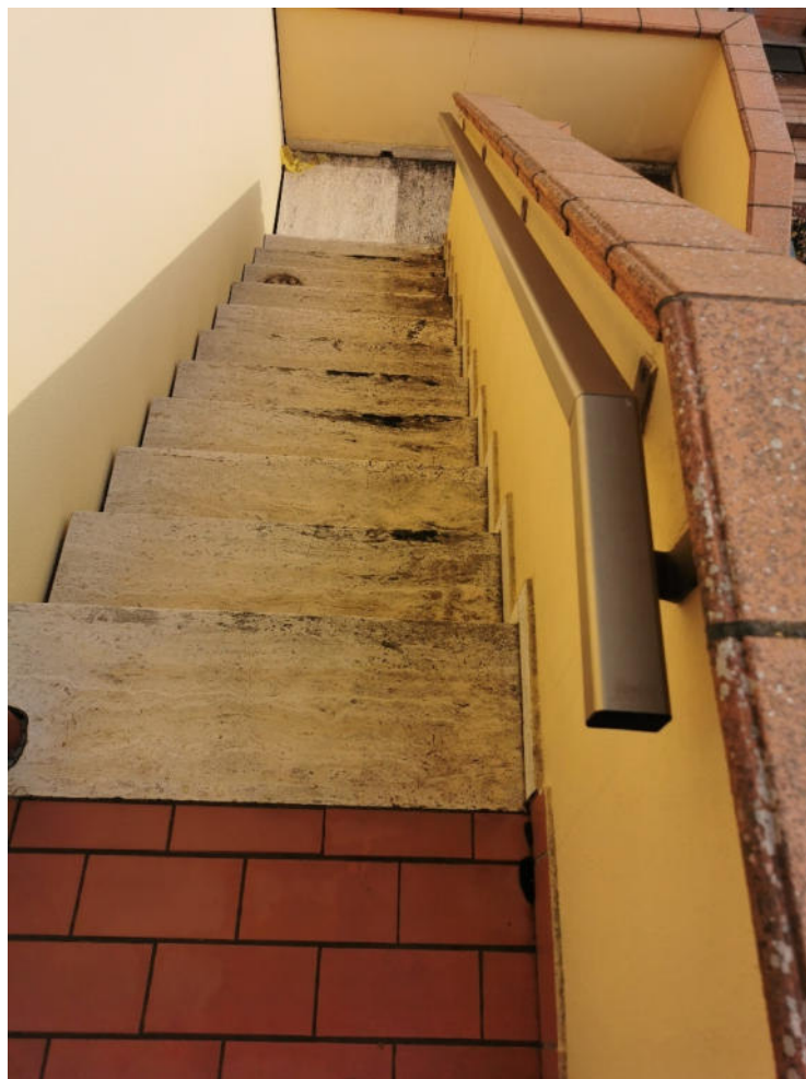
FOTOGRAFIA N. 2 -scala di accesso esclusiva
