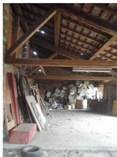
Piano primo con copertura "a vista"
