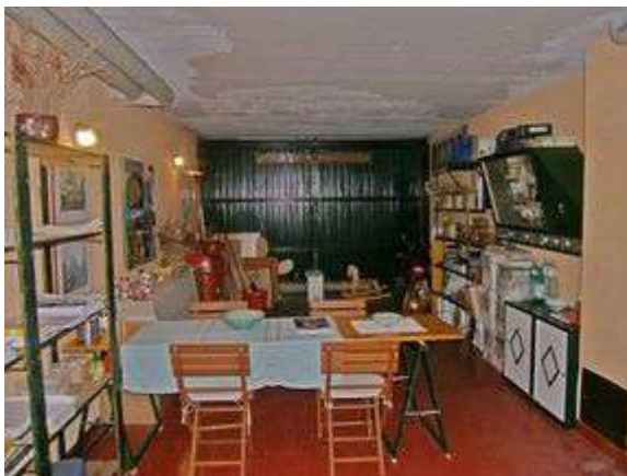
Vista box auto verso serranda di ingresso
