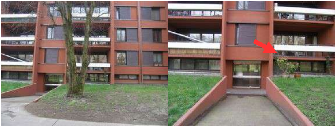
Vista dettaglio fronte su giardino
