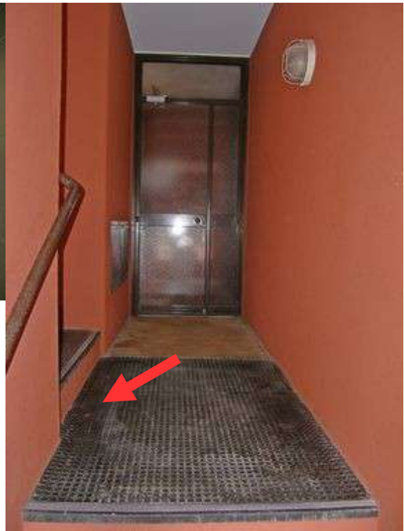
Vista vano scala
