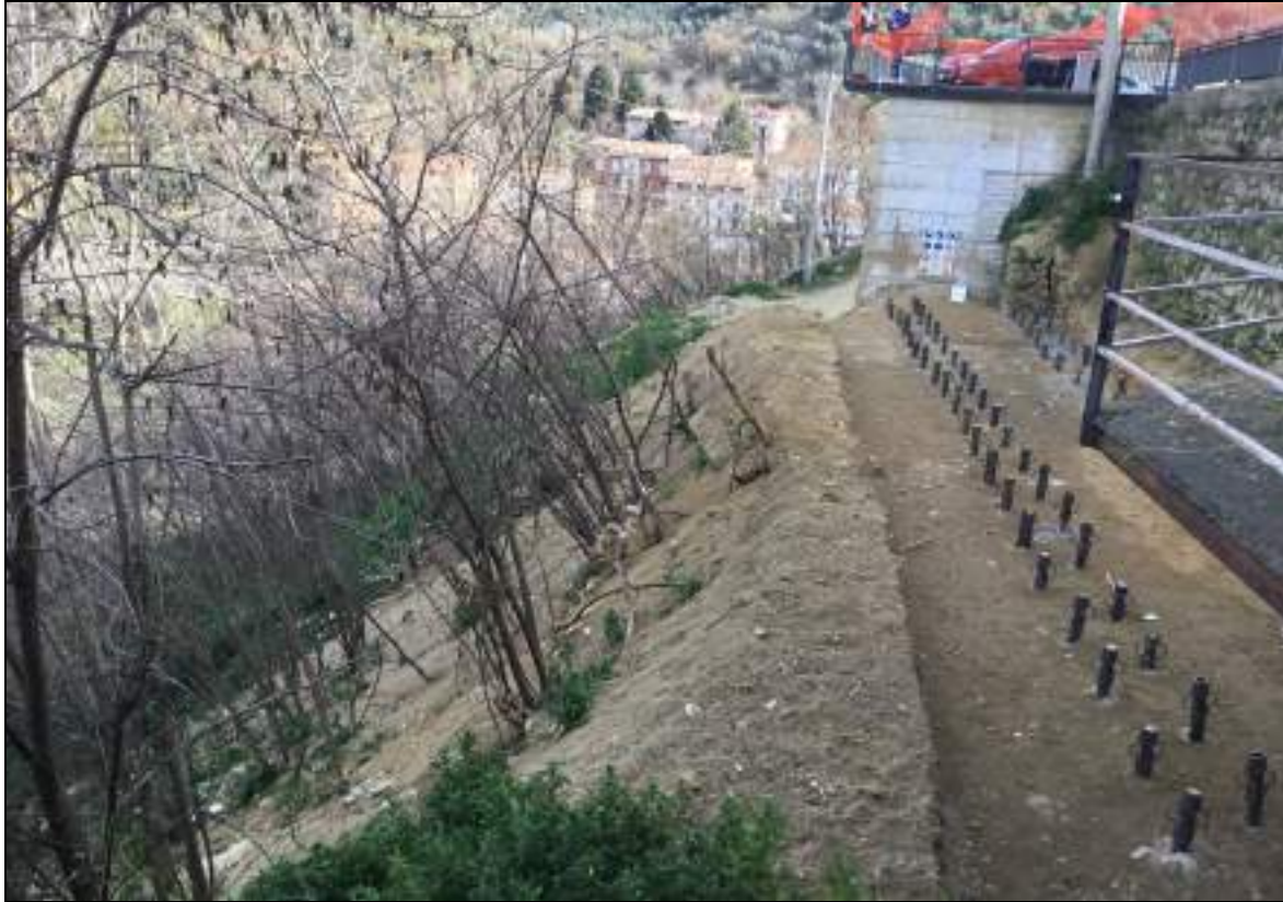
Fotografia sopralluogo terreno in oggetto
