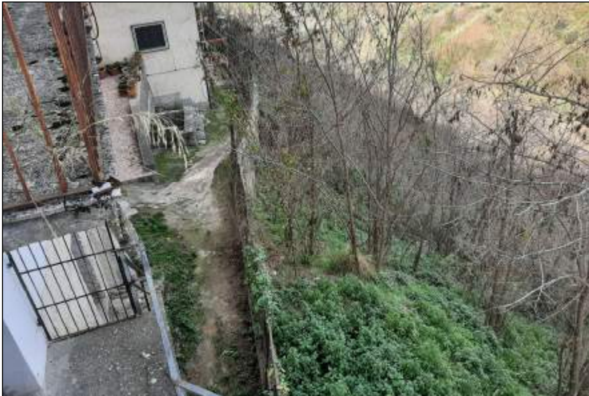
Fotografia sopralluogo terreno in oggetto
