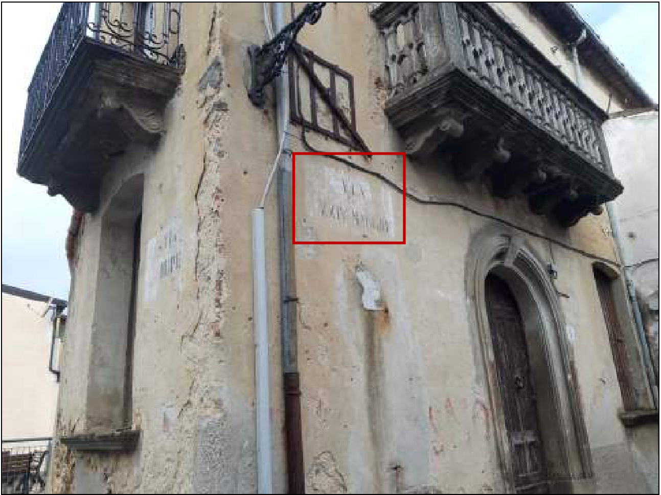
Particolare vista segnaletica toponomastica fabbricato adiacente (via XXIV Maggio)
