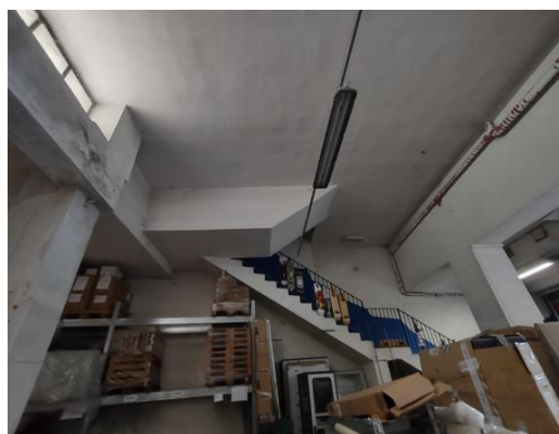
Scala di accesso al piano superiore
