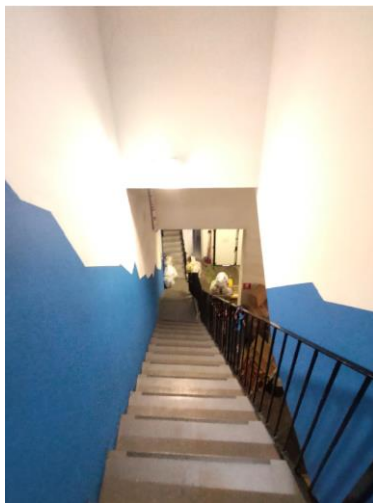
Scala interna al magazzino
