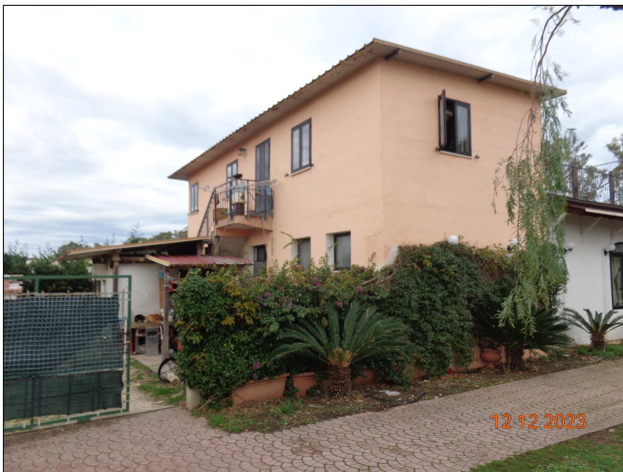
Figura 7. Corpo aggiunto sul retro del fabbricato e successivamente sopraelevato di un piano.
