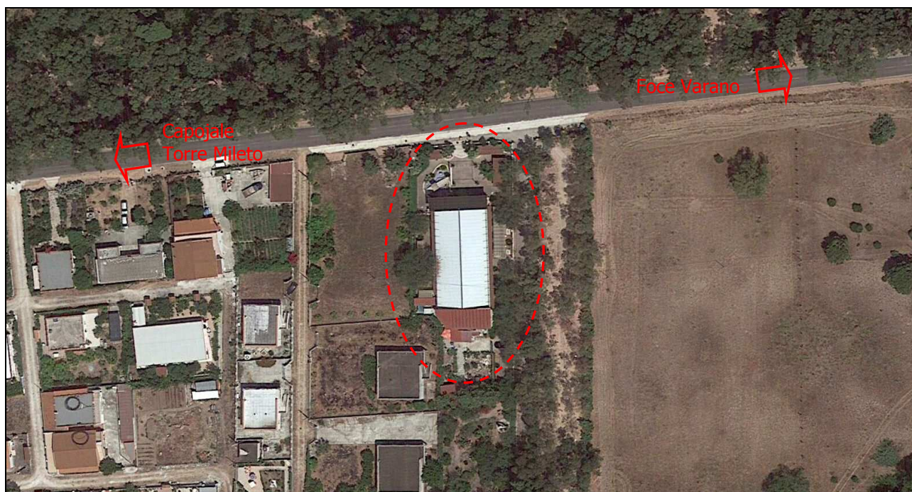
Figura 2. Vista satellitare dell'unità immobiliare pignorata, lungo la SP41.
