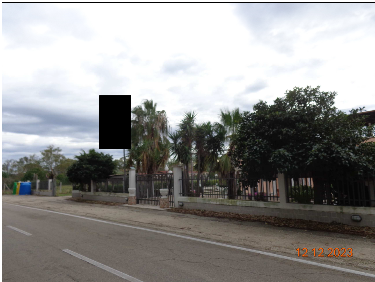
Figura 9. Ingresso al compendio lungo la strada provinciale SP41.
