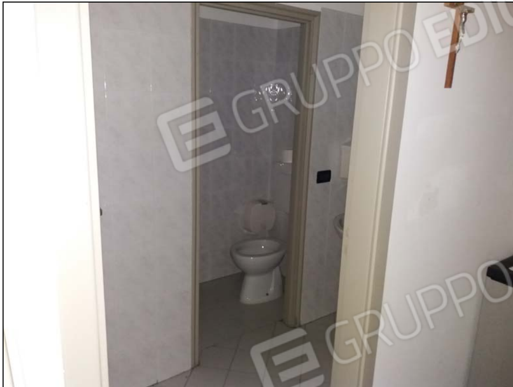
Foto n. 51: prospettiva “awc” e “wc” accessibili da reception - unità “U3”
