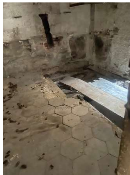
4 - interno unità immobiliare 2
