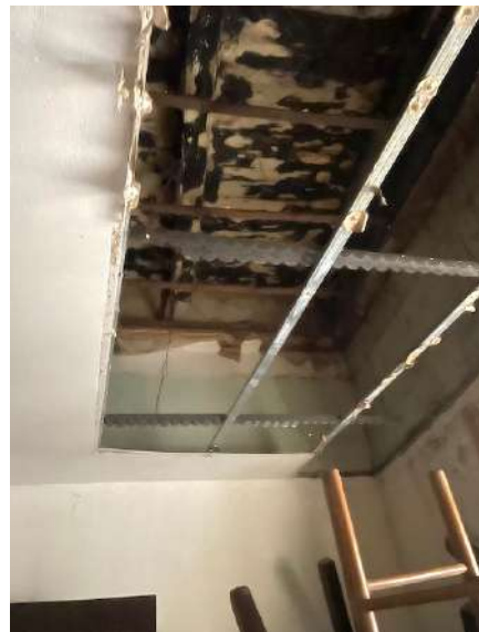
4 - finiture: controsoffitti abitazione
