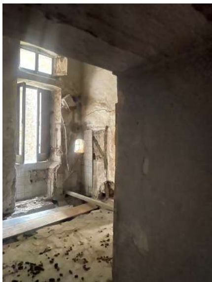
5 - interno unità immobiliare 2
