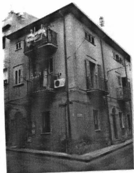
Foto n. 09 - Ingresso su via Filangeri.
