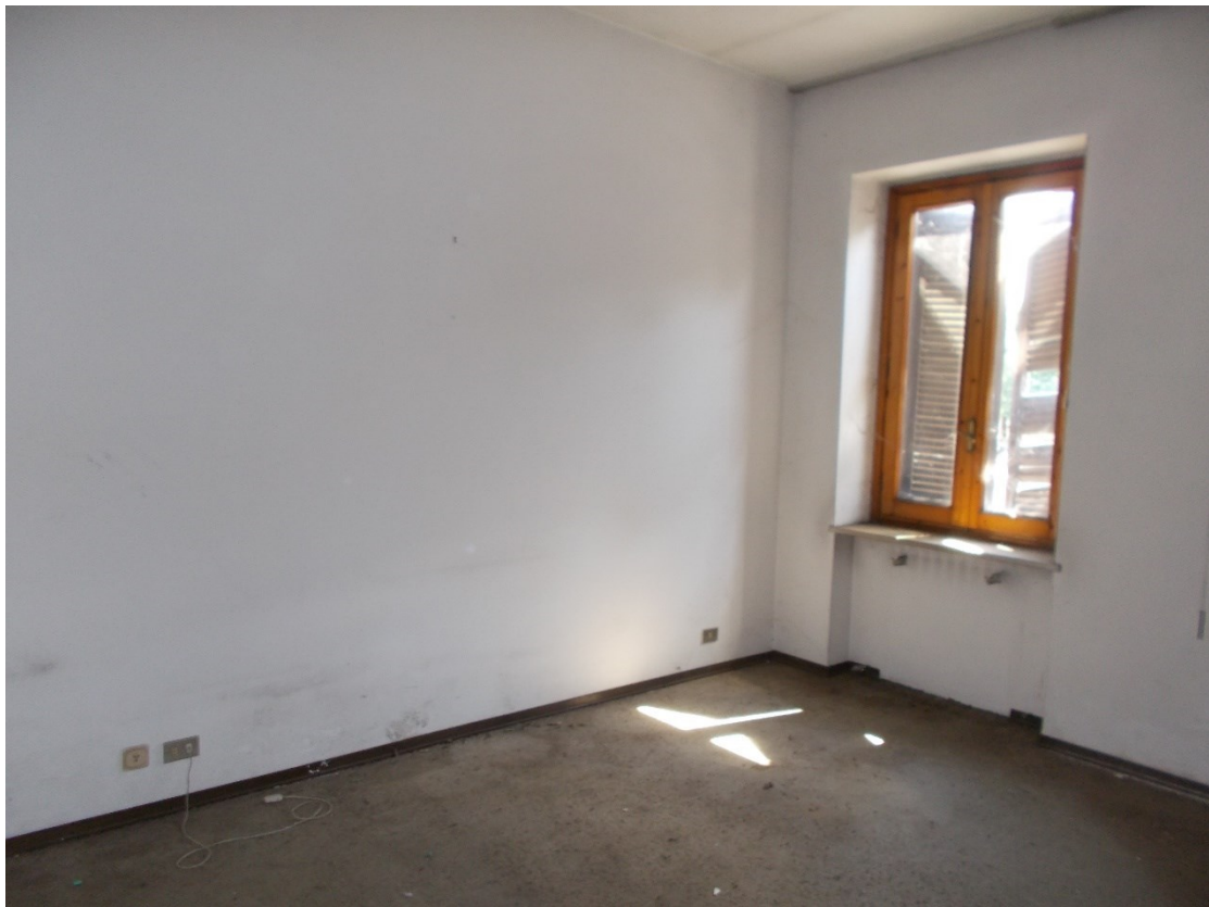
Foto 10. Fabbricato residenziale – particolare locali interni
