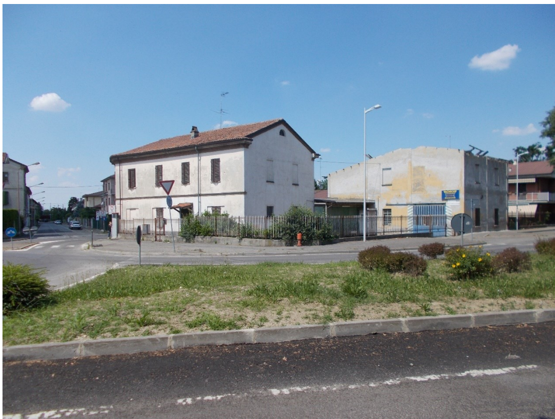
Foto 1. Complesso immobiliare - prospetto su Via Cuniolo - Viale A. De Gasperi
