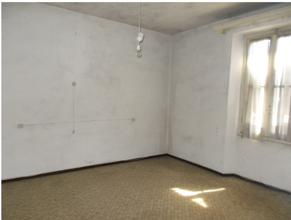
Foto 6. Fabbricato residenziale – particolare locali interni
