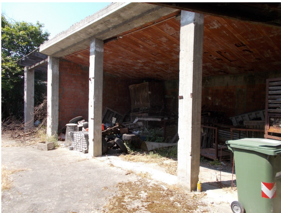
Foto 15. Tettoia ad uso deposito – pertinenza del fabbricato residenziale
