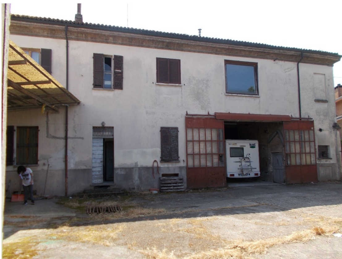
Foto 2. Fabbricato residenziale – prospetto aggettante il cortile interno
