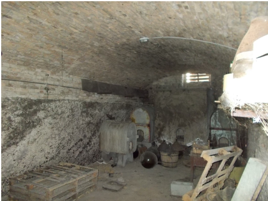
Foto 13. Fabbricato residenziale – particolare cantina
