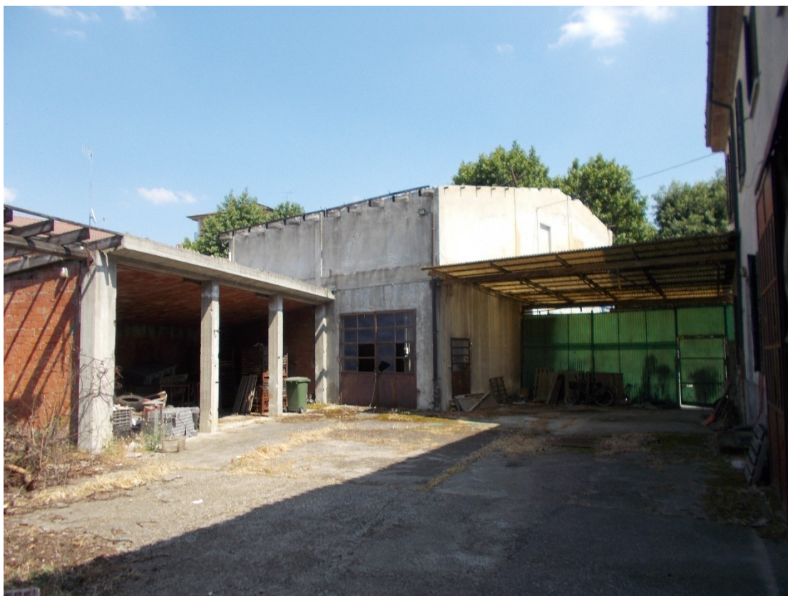
Foto 14. Fabbricato artigianale – con adiacenti tettoie, prospetto aggettante il cortile interno
