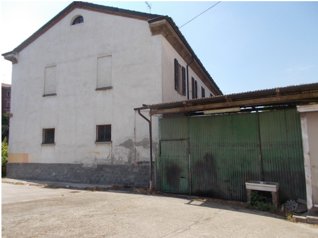
Foto 3. Fabbricato residenziale con attigua tettoia – prospetto est
