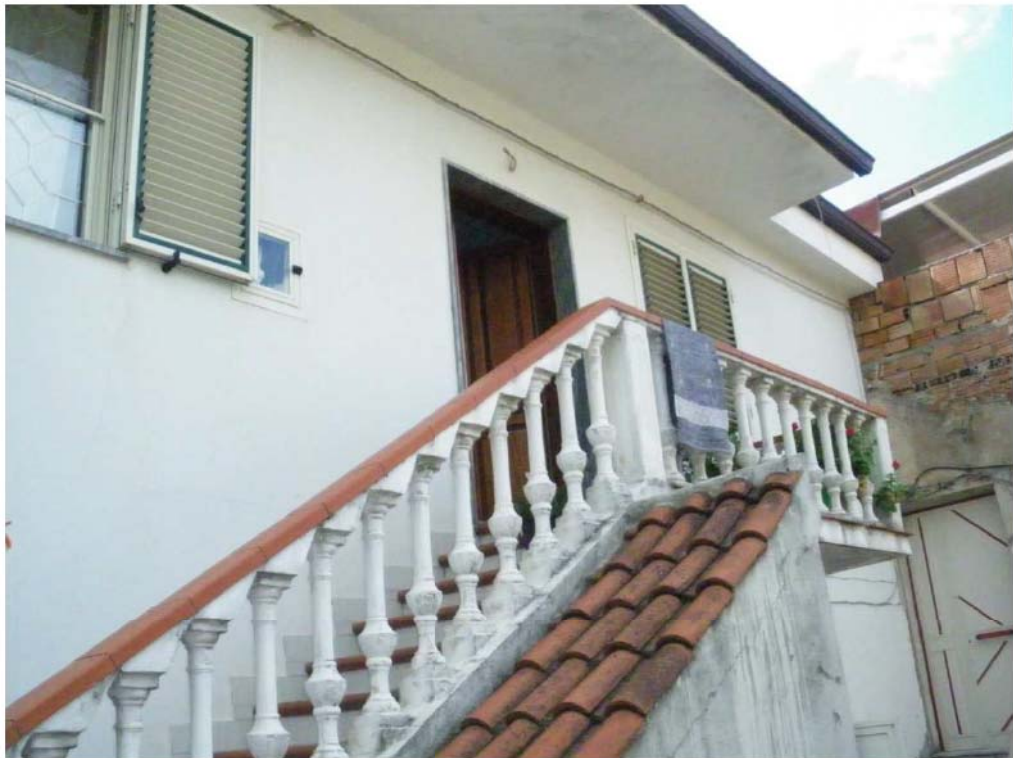
FOTO N° 10 – SCALA D'ACCESSO AL PRIMO PIANO
