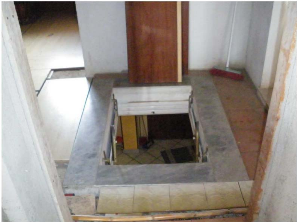
FOTO N° 18 – BOTOLA D'ACCESSO AL PIANO SECONDO
