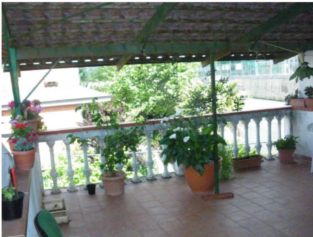
FOTO N° 21 – ALTRA VISTA DELLA TERRAZZA
