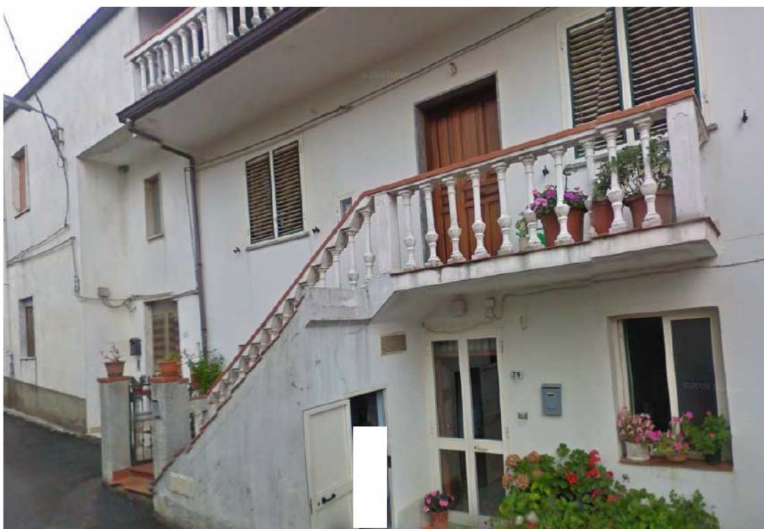
FOTO N° 2 – VISTA FACCIATA PROSPICIENTE IL VIALE GRANDINETTI – INGRESSO PIANO TERRA E PIANO PRIMO
