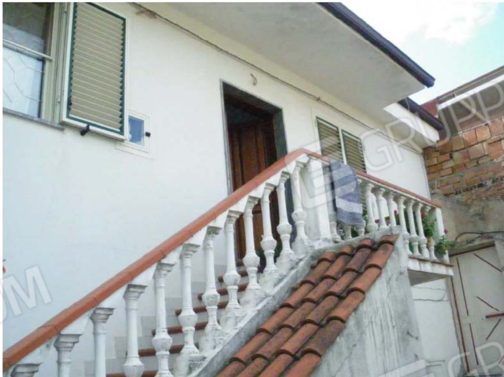
FOTO N° 10 – SCALA D'ACCESSO AL PRIMO PIANO
