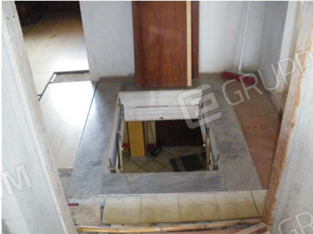
FOTO N° 18 – BOTOLA D'ACCESSO AL PIANO SECONDO
