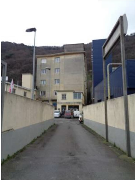
Vista ingresso da Lungobisagno Istria
