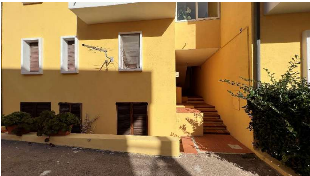
Figura 6 – Viste della facciata posteriore del bene oggetto di pignoramento
