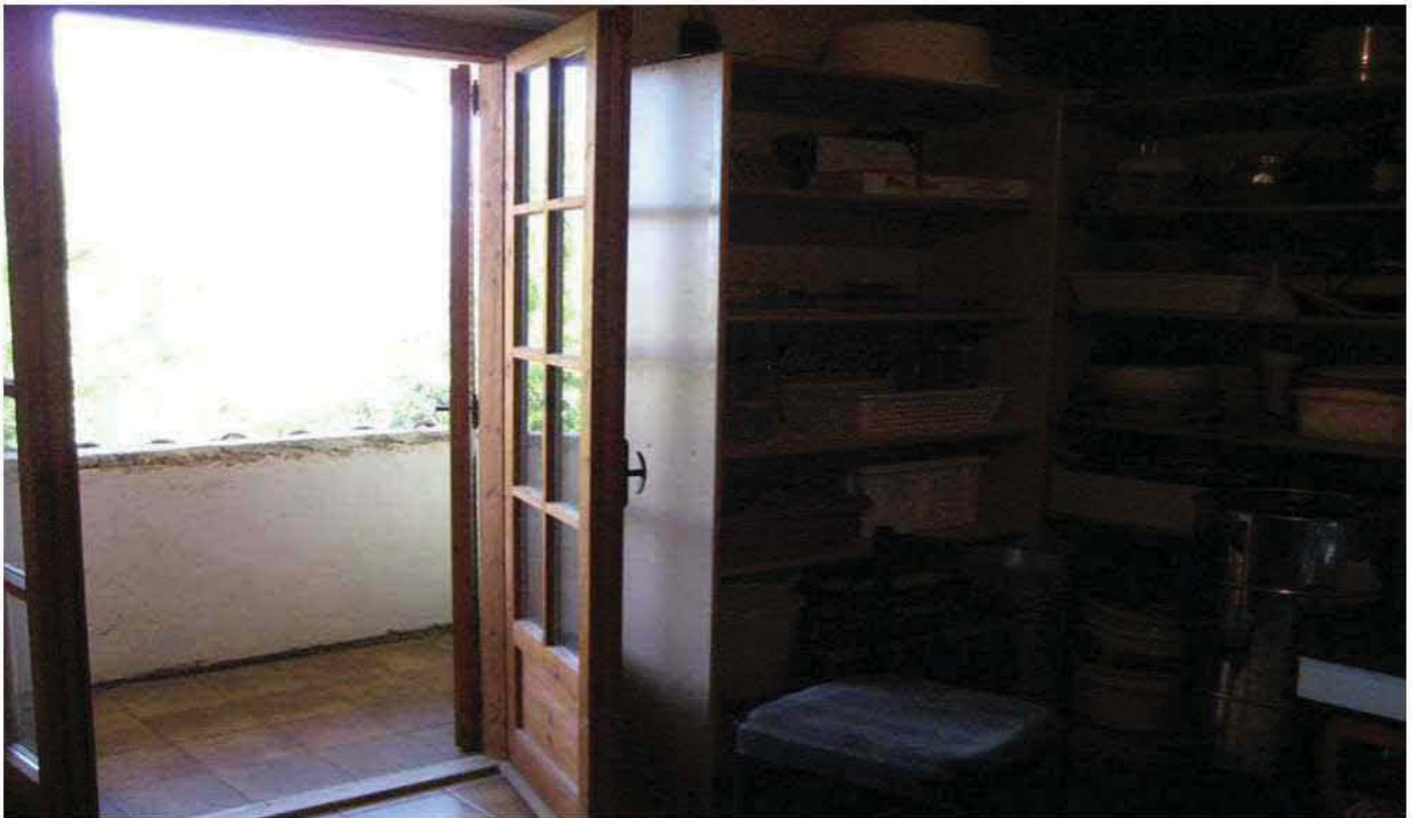
Foto 23 Balcone e Camera piano sottotetto
