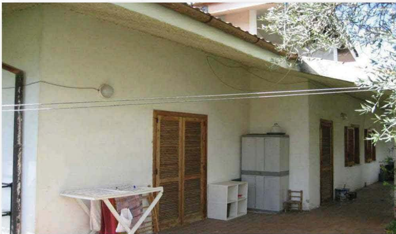
Foto 3 Vista posteriore immobile
