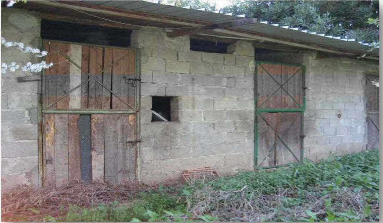
Foto 32 Manufatto sito sul terreno
