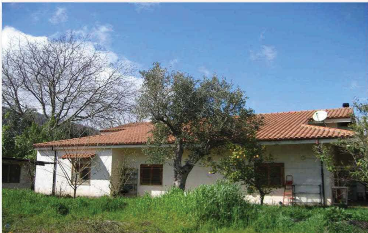
Foto 4 Vista posteriore immobile
