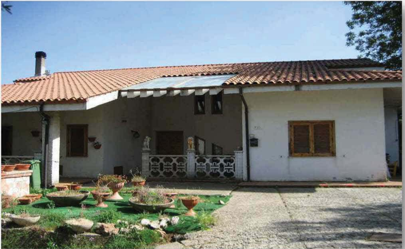
Foto 1: Vista anteriore, ingresso immobile
