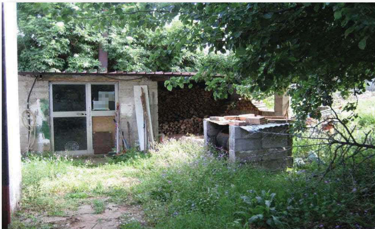
Foto 30 Manufatti adiacenti all'immobile
