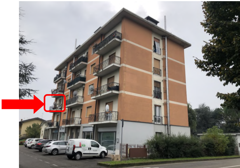
Esterno edificio lungo via J.F. Kennedy
