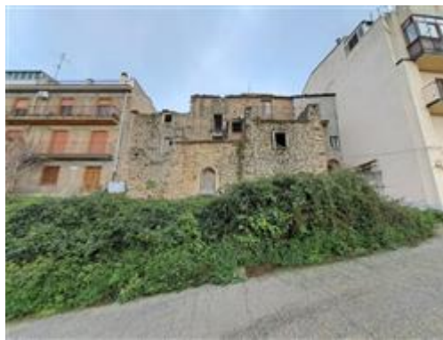
Vista dell'immobile dalla via Barbaraceto
