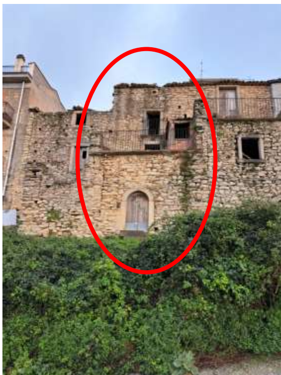
Foto n. 14 - Prospetto immobile su Via Camposanto.
