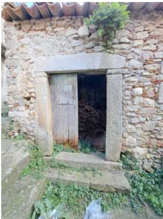
Foto n. 7 - Porta di ingresso immobile part.IIa 423 sub 3
