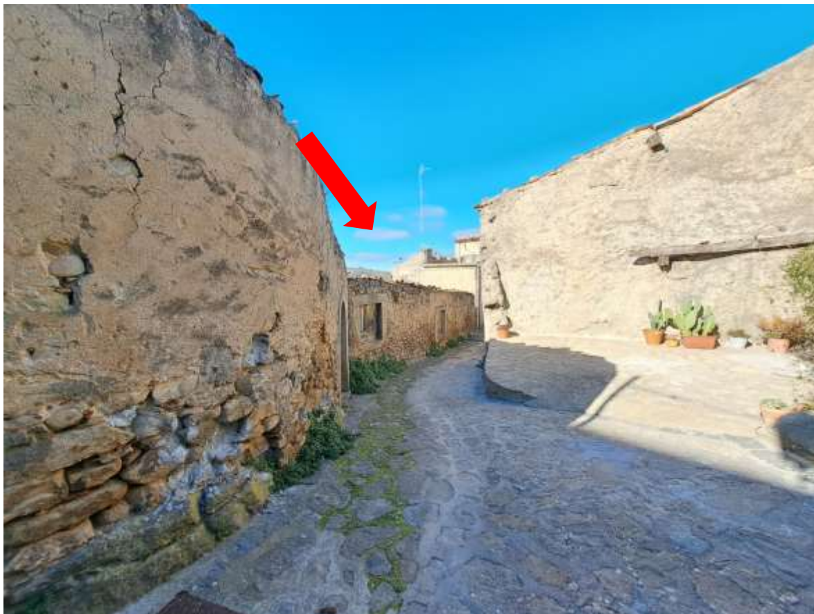
Foto n. 6 - Via Spirito Santo con indicazione degli immobili
