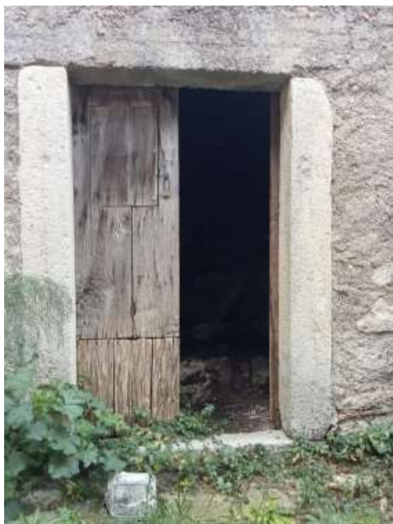
Foto n. 9 - Porta di ingresso immobile part.IIa 423 sub 4
