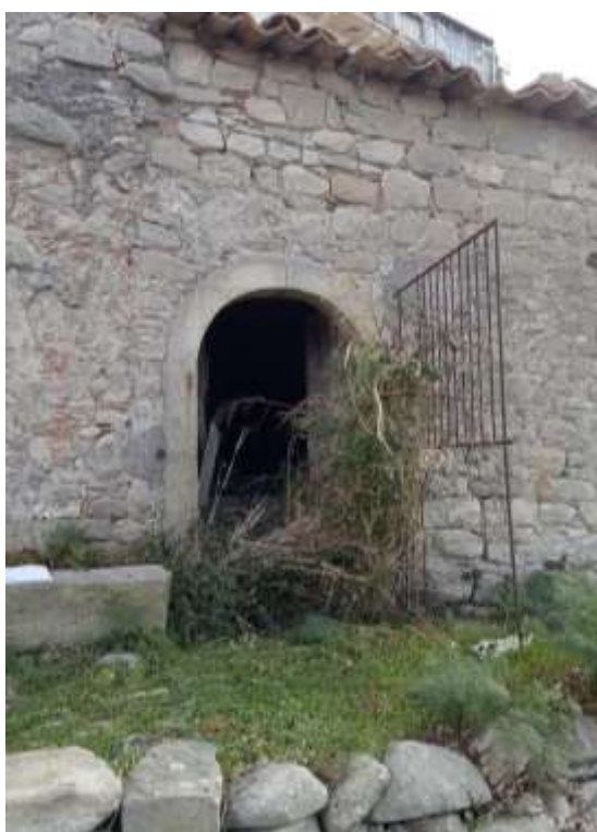
Foto n. 12 - Vano di accesso all'immobile
