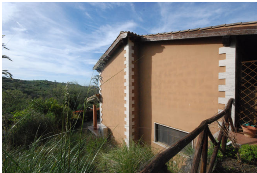
Foto 5 La finestra di una camera vista dalla corte al piano primo
