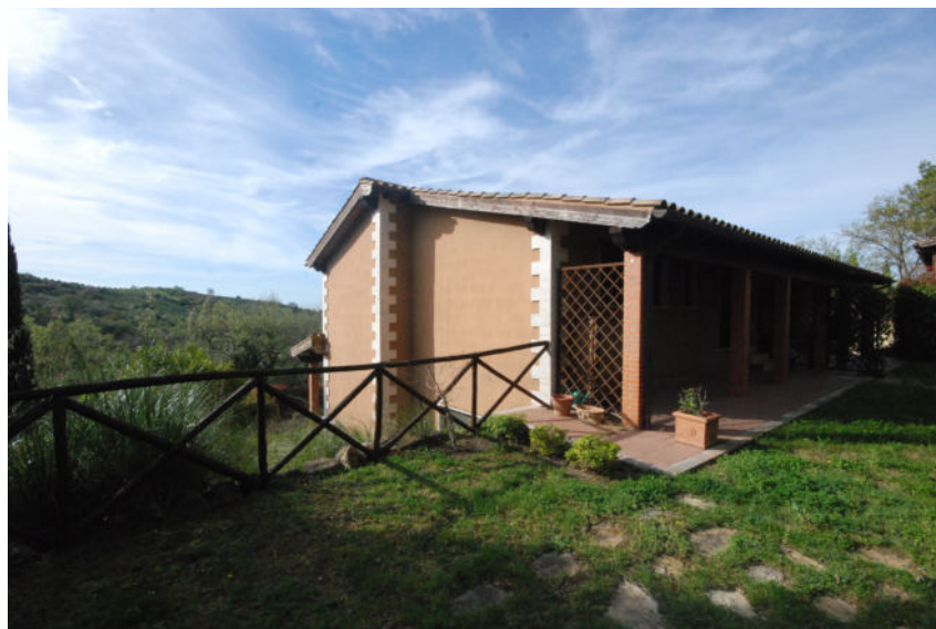
Foto 4 L'edificio al piano primo
