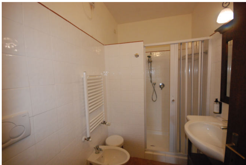
Foto 20 Il termo-arredo di un secondo bagno
