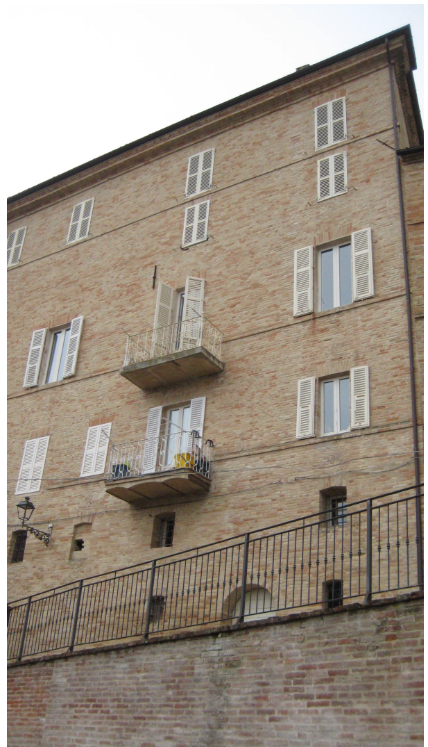
Prospetto di via Palestro
