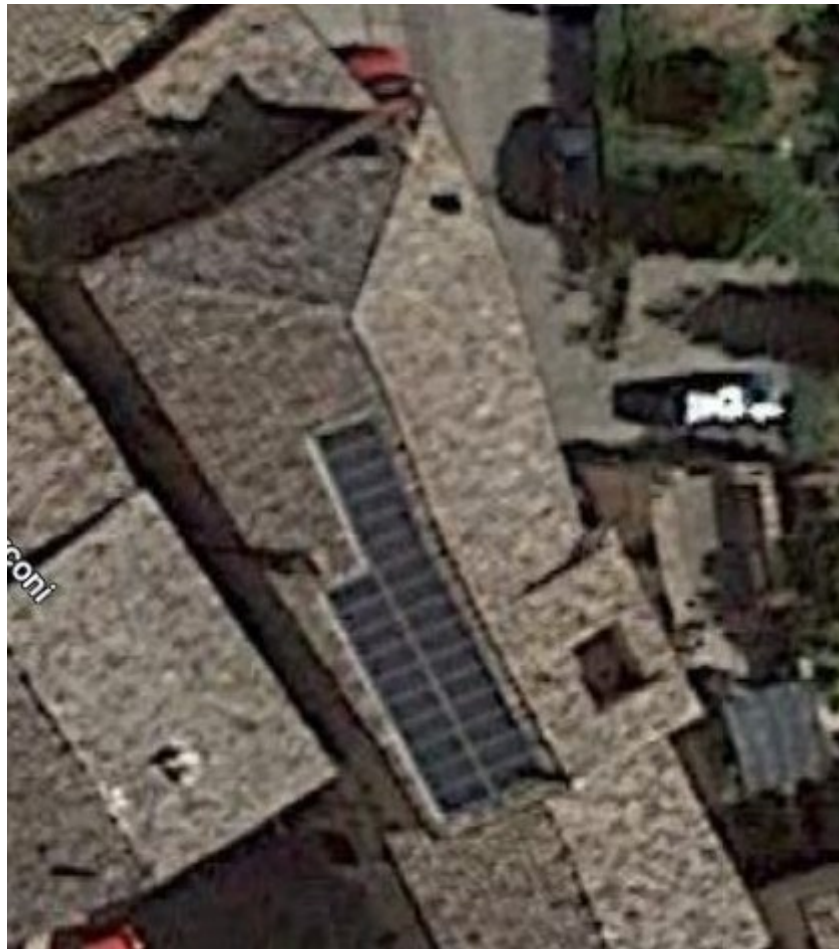
vista del tetto e dell'impianto fotovoltaico
