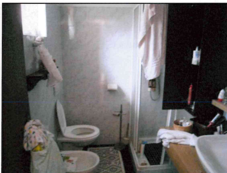
FOTO 62 PIANO PRIMO. VISTA INTERNA BAGNO DELLA CAMERA DELLA FOTO PRECEDENTE.
