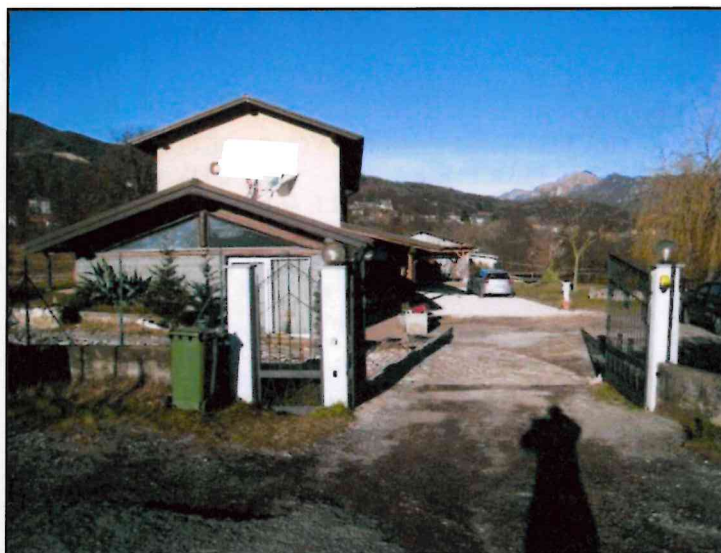
FOTO 1 VISTA DELL'INGRESSO CARRAIO E PEDONALE AL COMPENDIO IMMOBILIARE OGGETTO DI PROCEDURA ESECUTIVA.
