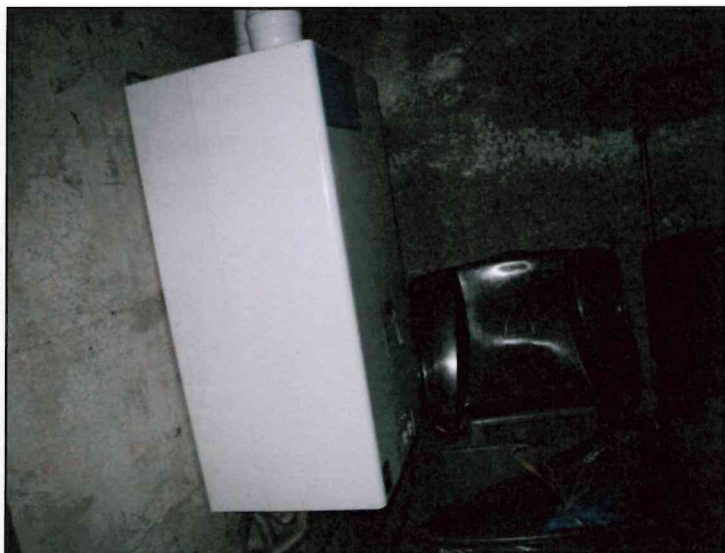
FOTO 31 PIANO TERRA. ALTRA VISTA RIPOSTIGLIO DELLA FOTO PRECEDENTE.
