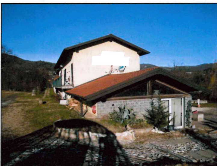
FOTO 3 ALTRA VISTA DEL FABBRICATO OGGETTO DI PROCEDURA ESECUTIVA IDENTIFICATO DAL MAPPALE 461 SUB. 501 RIPORTATO NELLA SCHEDA CATASTALE N° 1.
