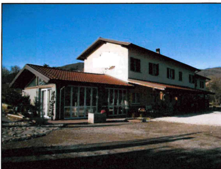
FOTO 2 VISTA DEL FABBRICATO OGGETTO DI PROCEDURA ESECUTIVA IDENTIFICATO DAL MAPPALE 461 SUB. 501 RIPORTATO NELLA SCHEDA CATASTALE N° 1.
