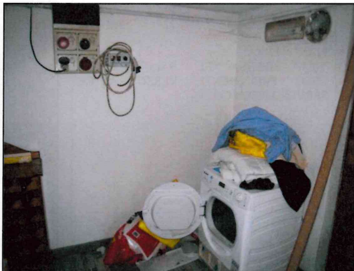
FOTO 28 PIANO TERRA. VISTA RIPOSTIGLIO COLLEGATO ALLA CUCINA.
