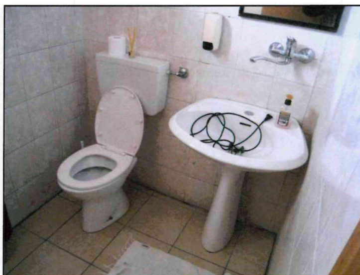
FOTO 26 PIANO TERRA. VISTA INTERNA ALTRO SERVIZIO IGIENICO.
