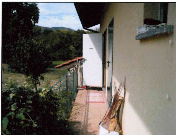
FOTO 58 PIANO PRIMO. VISTA ALTA PORZIONE DI BALCONE(BALLATOIO) DI DISIMPEGNO ALTRE CAMERE.
