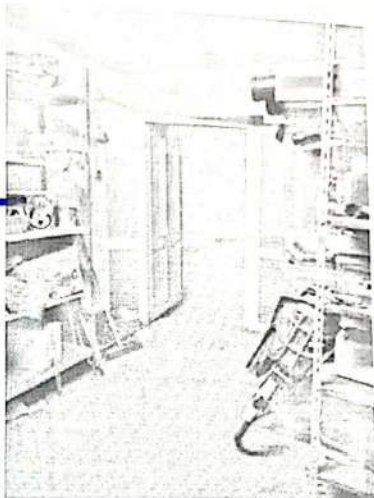
Interno del sub.35 al piano seminterrato
