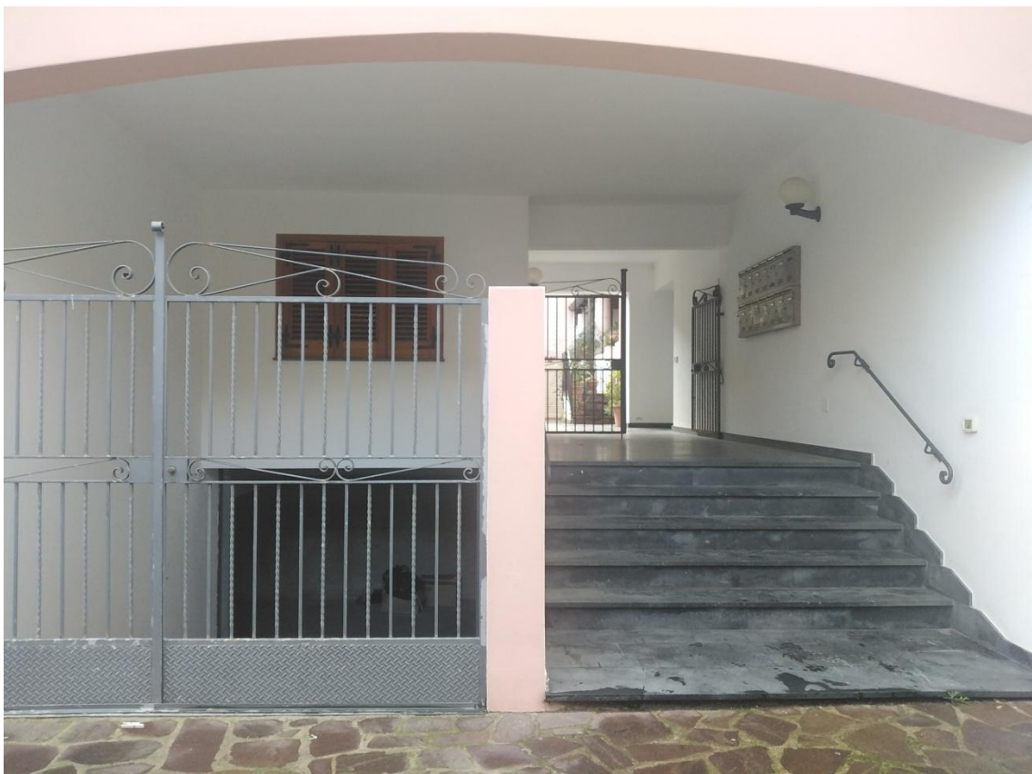
Foto 4 – CONDOMINIO “RESIDENCE ARANCIO”: ACCESSI, CARRABILE E PEDONALE, SU VIA TORRENTE BOCCETTA.
