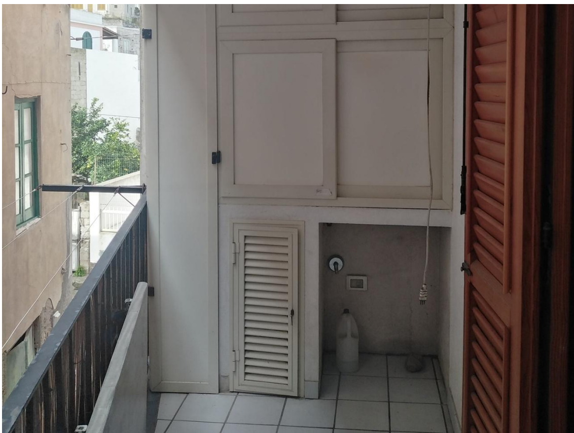
Foto 40 – SUB.15: LOGGIA (SU VIA UNCI).
