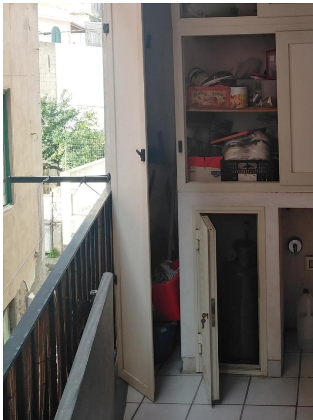
Foto 41 – SUB.15: LOGGIA (SU VIA UNCI).
