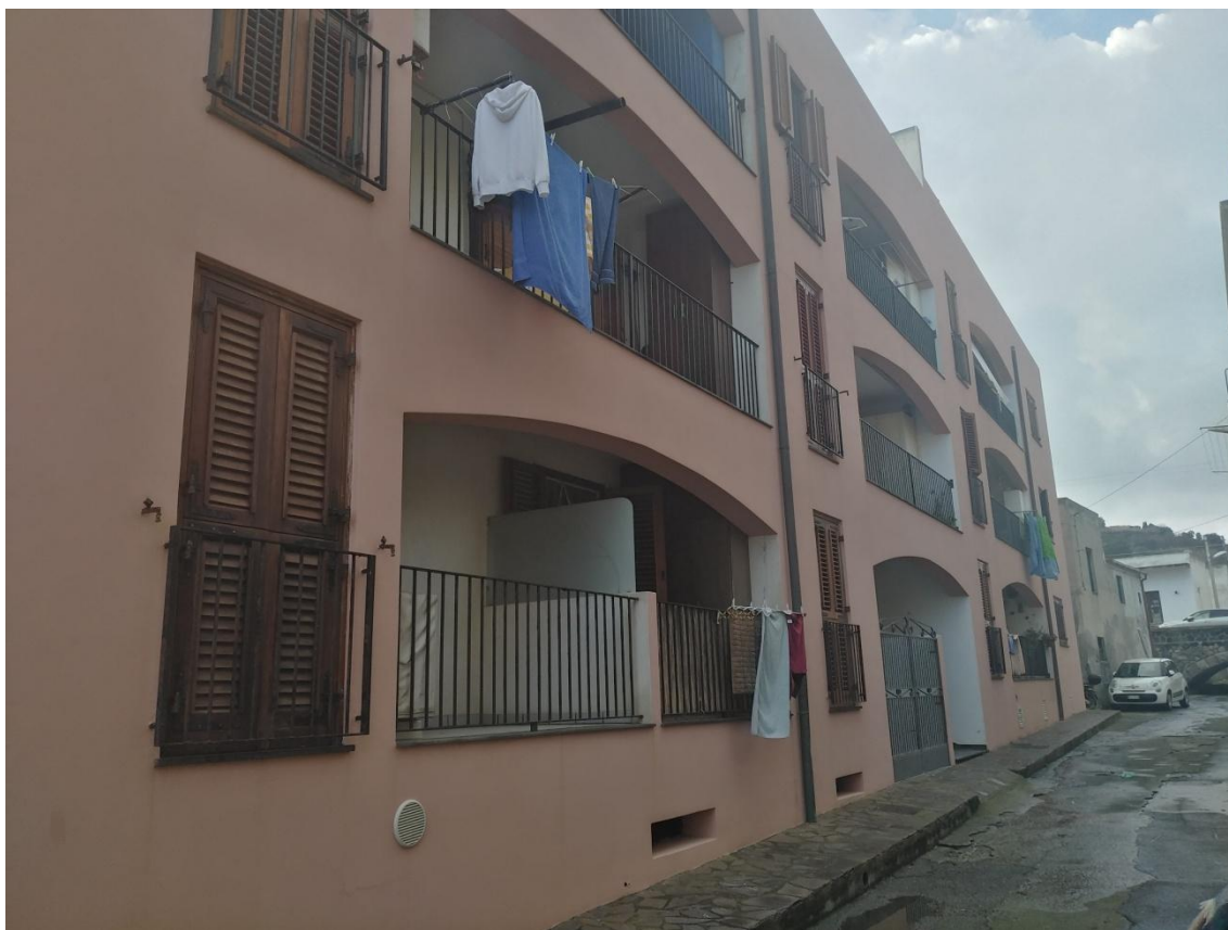
Foto 1 – CONDOMINIO “RESIDENCE ARANCIO”: PROSPETTO SU VIA TORRENTE BOCCETTA.
