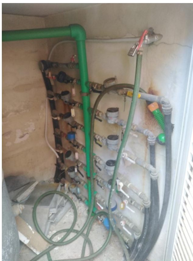
Foto 8 – CONTATORI IDRICI DELLE VARIE UU.II..
