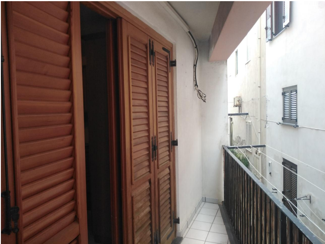
Foto 39 – SUB.15: LOGGIA (SU VIA UNCI).
