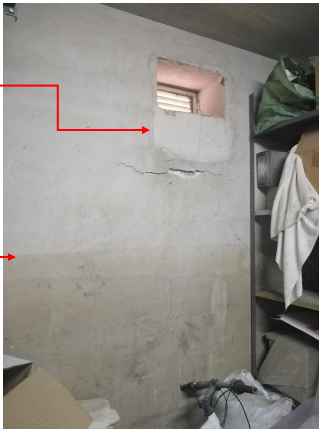
Foto 22 – SUB.35: LUCE SU VIA TORRENTE BOCCETTA.
