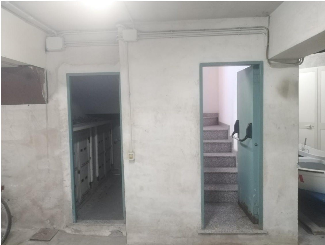
Foto 15 – GARAGE: A SIN. EX VANO CONTATORI S.E.L. (“D”) E, A DX, ACCESSO AL VANO SCALA.
