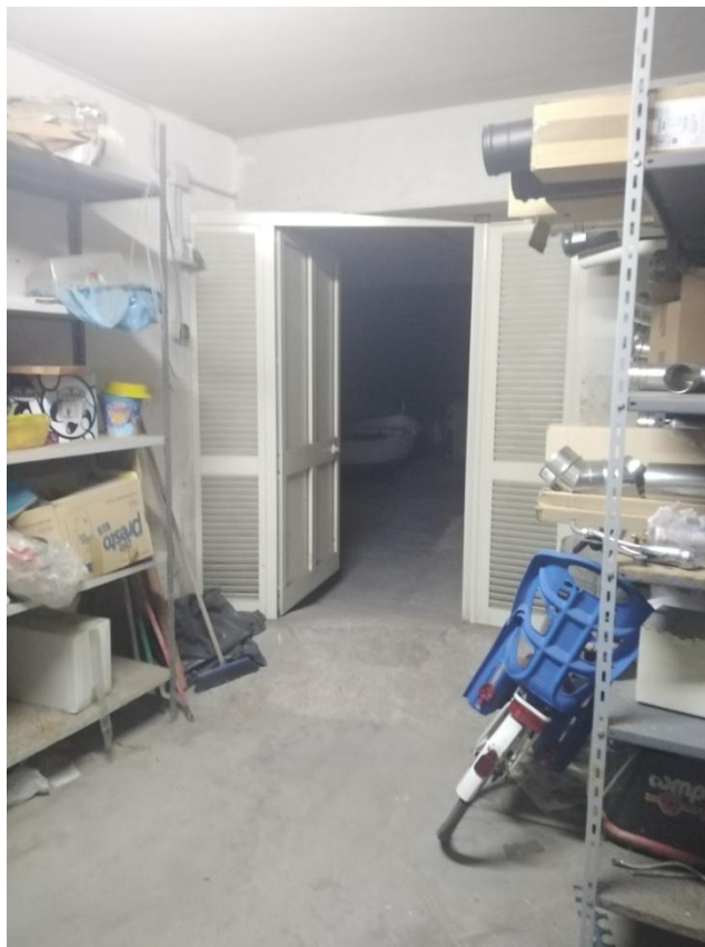
Foto 23 – SUB.35: INTERNO (LA PARETE ALLA SINISTRA E LE CHIUSURE IN ALLUMINIO NON RISULTANO IN PROGETTO).
