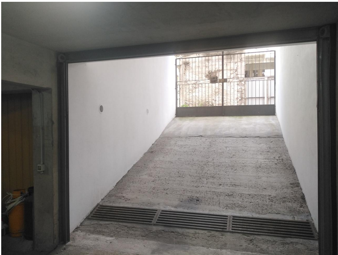
Foto 17 – RAMPA GARAGE (VEDUTA DAL BASSO).
