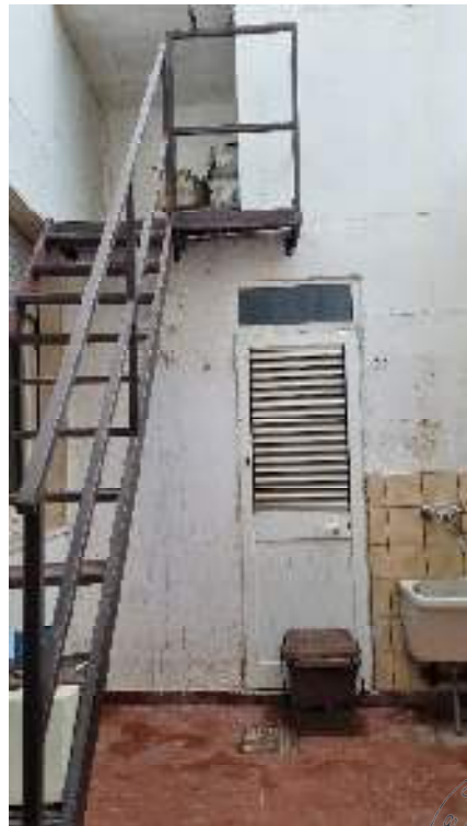
Foto n. 3 – Immobile di vico OLMI
