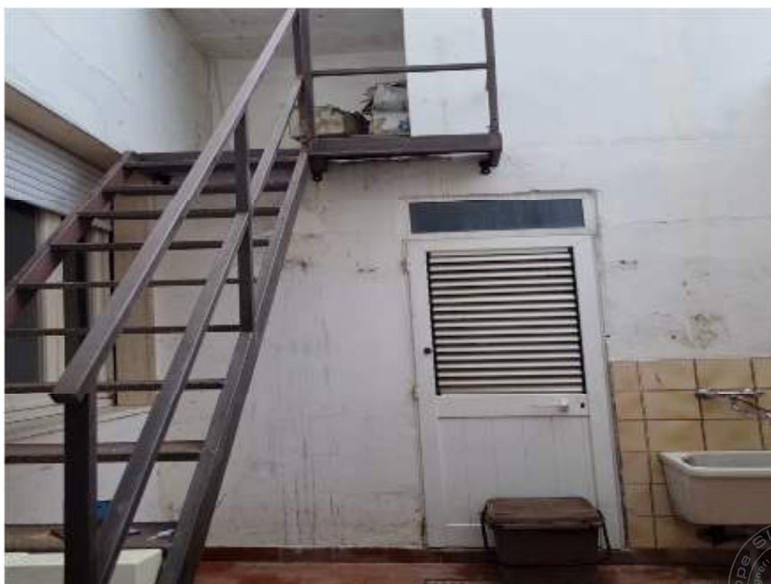
Foto n. 2 – Immobile di vico OLMI
