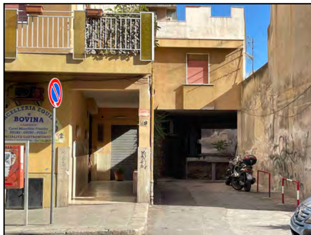
Fig.6 Accesso al piano scantinato civ.46
