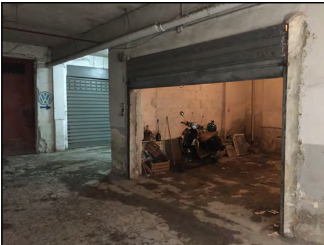
Fig.11 Veduta dalla corsia di disimpegno
