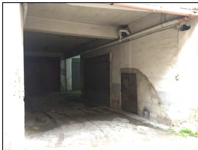
Fig.10 Corsia di disimpegno e garage pignorato
