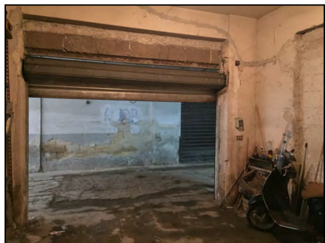
Fig.16 Veduta dall'interno del garage
