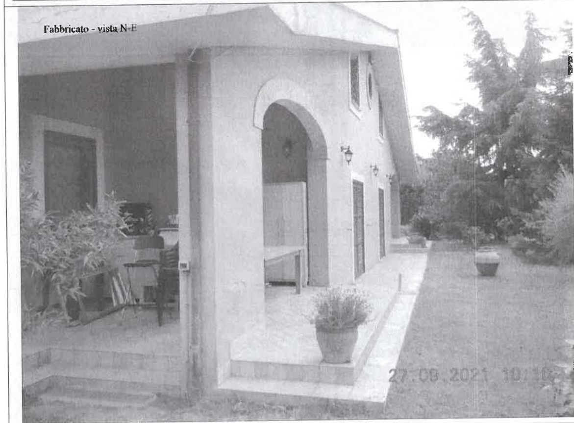
Foto esterno del fabbricato – Lato N-E
