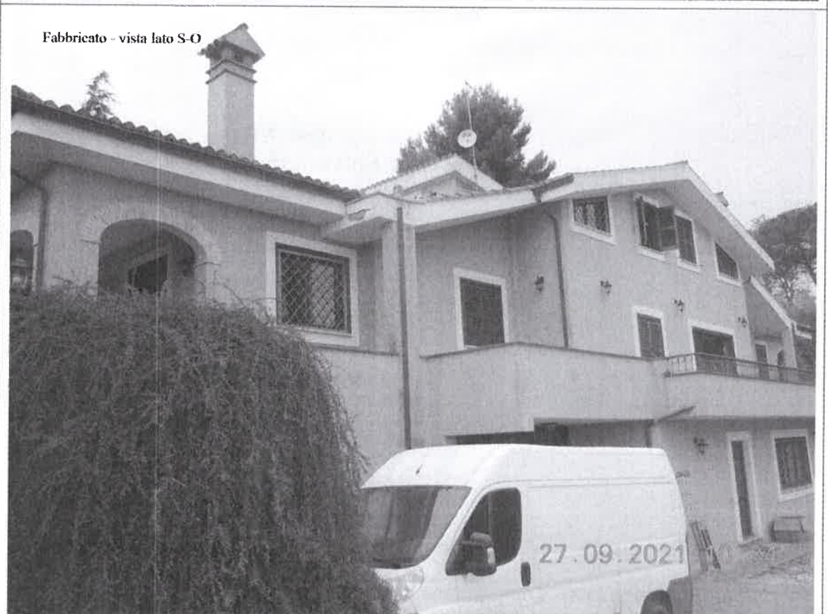
Foto esterno del fabbricato – Lato S-O
