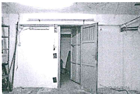
Altra Vista del Box sull'uscita con le due porte.
