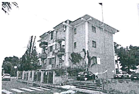
Prospetto su via Primo Longobardo
