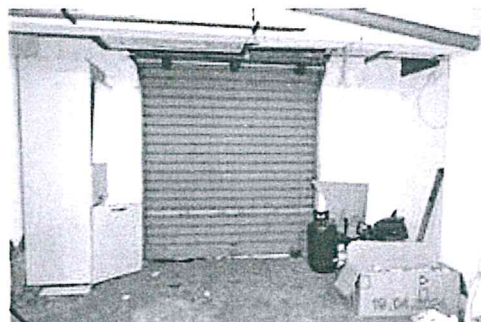
Vista Interna del Box.
