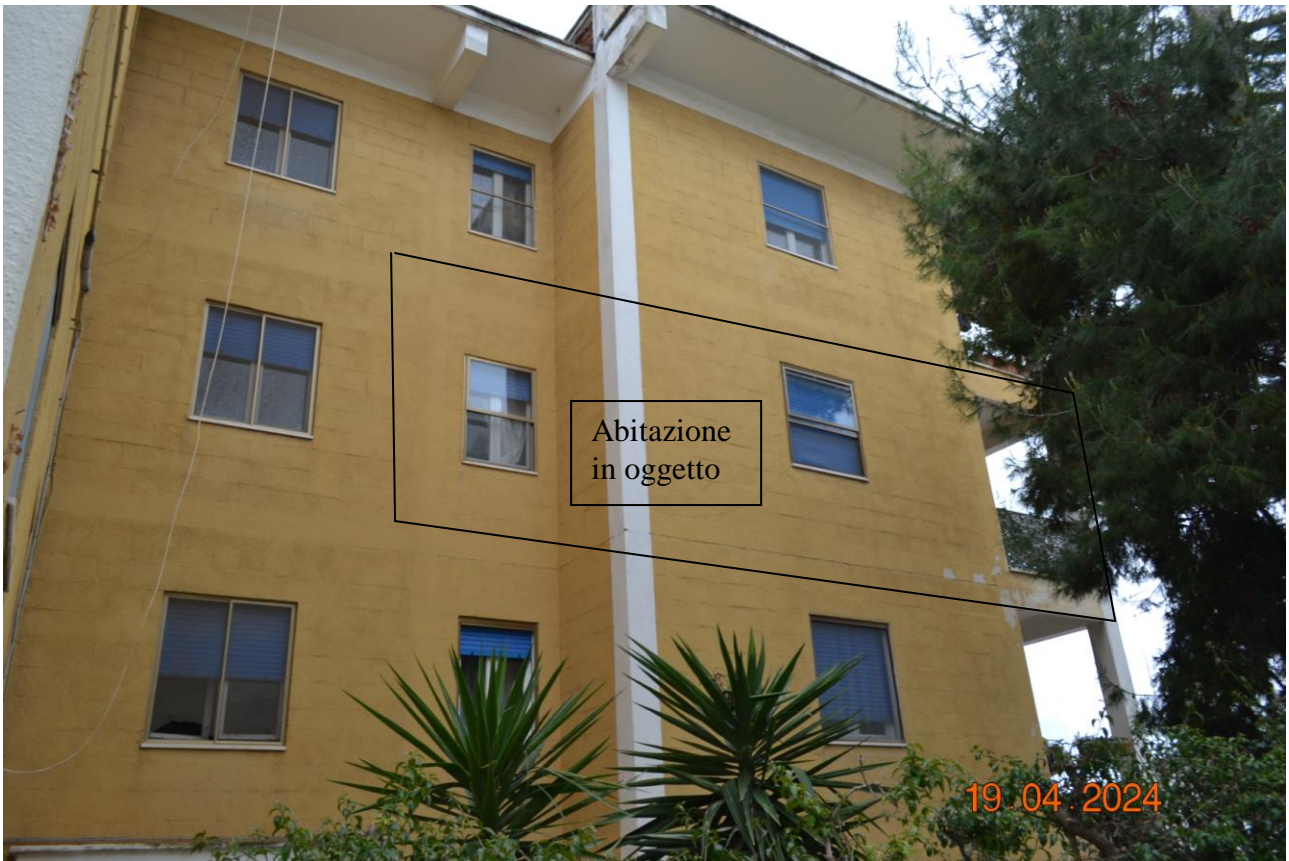
FOTOGRAFIA 5: Particolare del Prospetto in cui vi è il Portone di Ingresso
