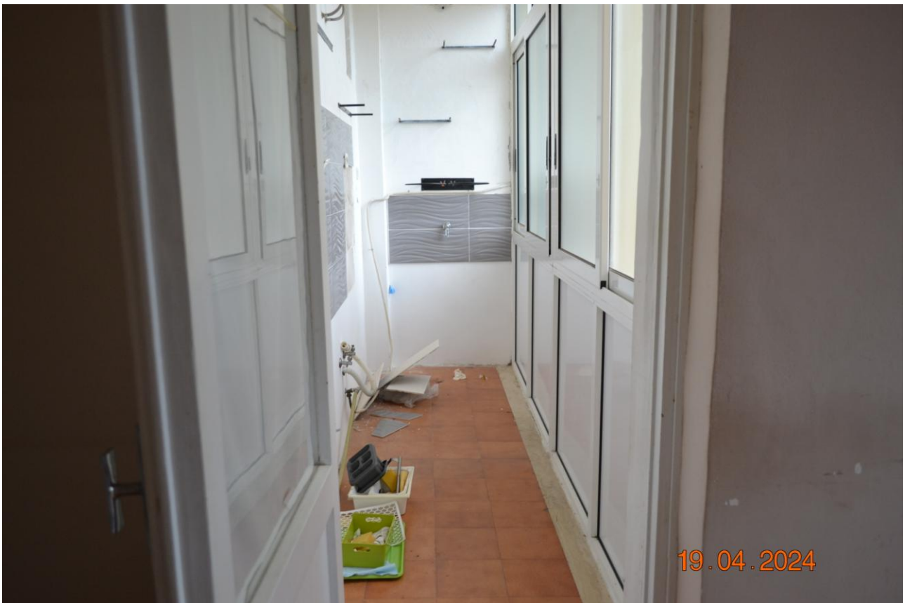
FOTOGRAFIA 20: Angolo Cottura adiacente alla Cucina
