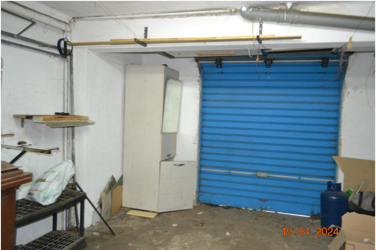
FOTOGRAFIA 35: Particolare dell'interno del Garage
