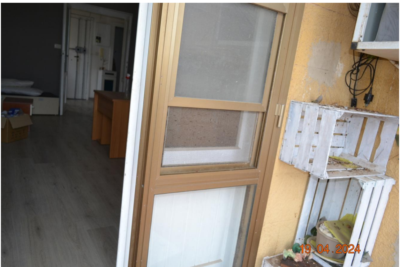
FOTOGRAFIA 28: Porta di comunicazione Soggiorno - Balcone
