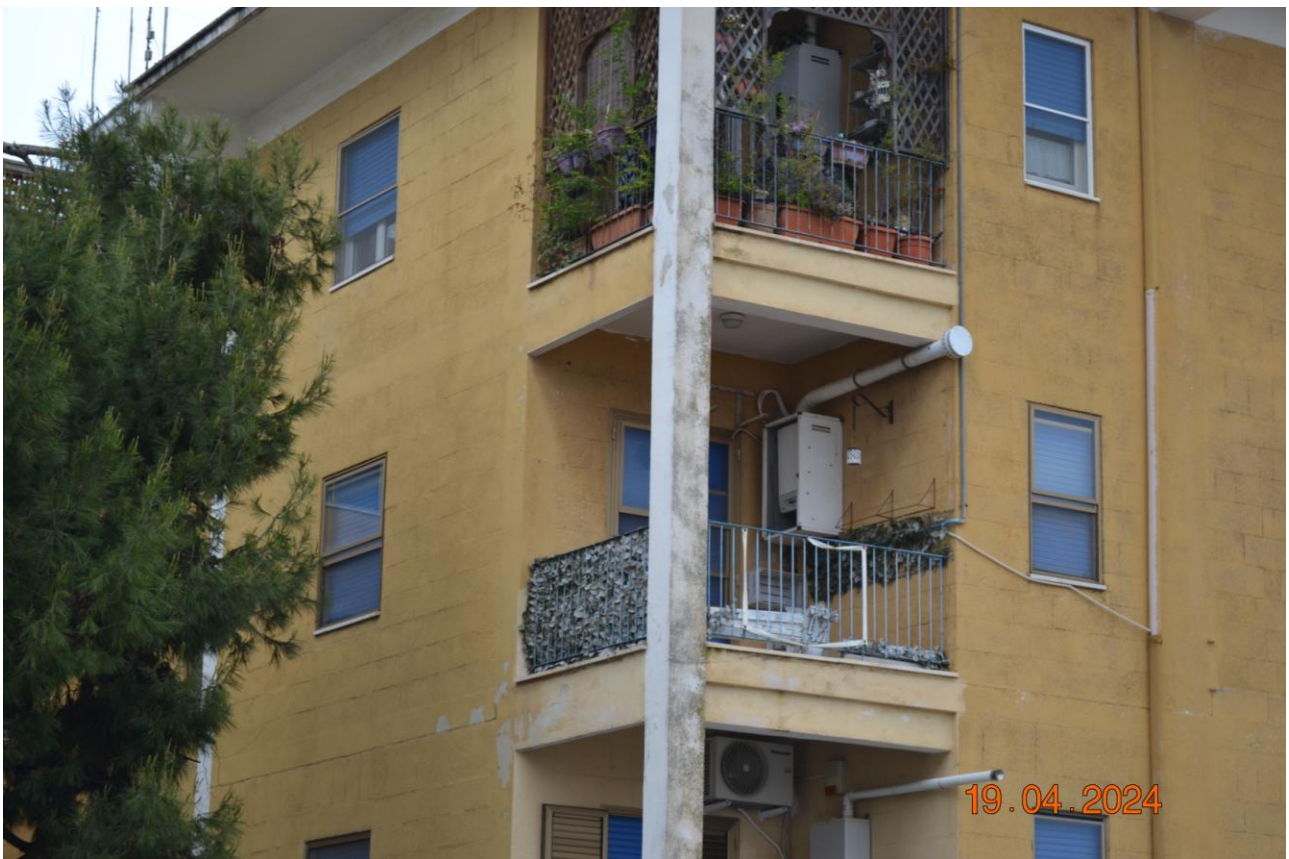
FOTOGRAFIA 4: Particolare del Balcone al Piano Secondo sul Prospetto principale
