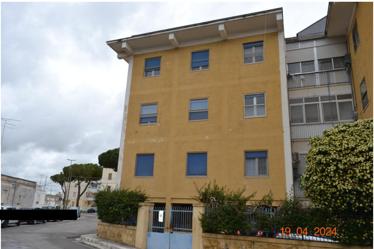
FOTOGRAFIA 6: Particolare del Prospetto e dell'Ingresso secondario sulla curva di Via Palermo
