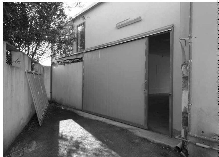
Figura 10 – Ripresa 8: Vista insieme esterna parete est accesso da Sub 15
