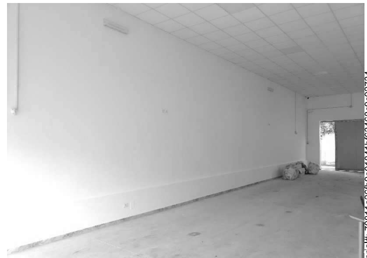
Figura 8 – Ripresa 6: Vista insieme parete nord
