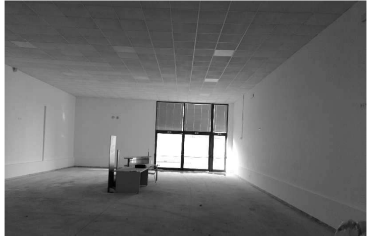
Figura 6 – Ripresa 4: Vista insieme su parete ovest - ingresso principale da Sub 32
