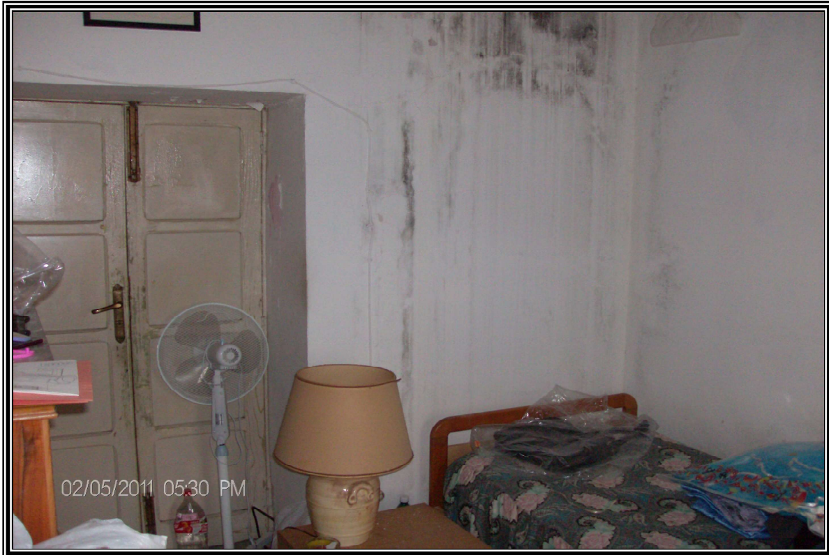
FOTOGRAFIA n. 9 – Vista dall'interno "Abitazione"
