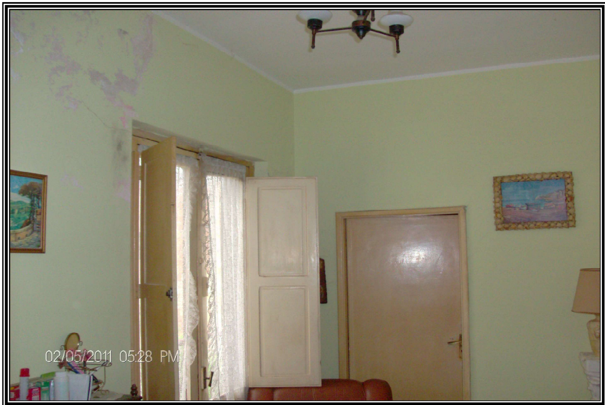
FOTOGRAFIA n. 7 – Vista dall'interno "Abitazione"
