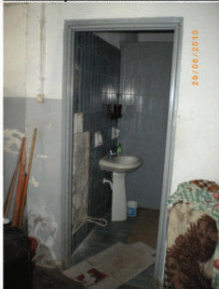
(Foto n. 9 - ingresso w.c.)
