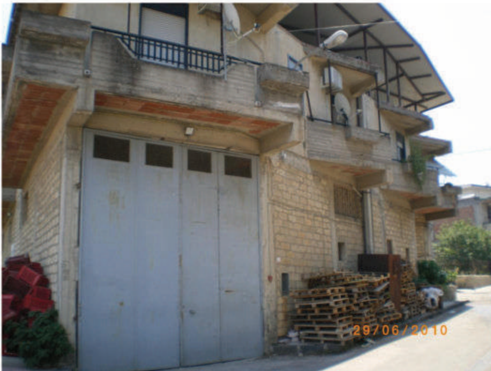
(FO-L1) foto n. 4 - u.n. 1.01 Fabbricato adibito a magazzino Fg 14 part.IIa n. 57 sub. 8 piano terra NCEU del Comune di Palagonia prospetto lato ovest Via D. Tempio ingresso per area carico merce;
