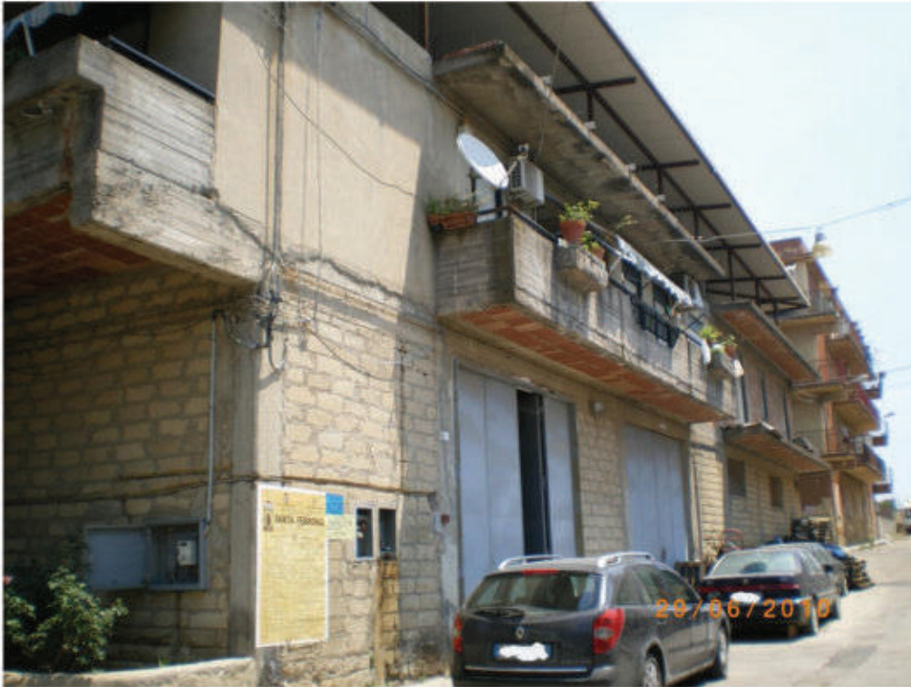
(FO-L1) foto n. 3 - u.n. 1.01 Fabbricato adibito a magazzino Fg 14 part.IIa n. 57 sub. 8 piano terra NCEU del Comune di Palagonia prospetto lato sud-ovest Via D. Cimarosa;
