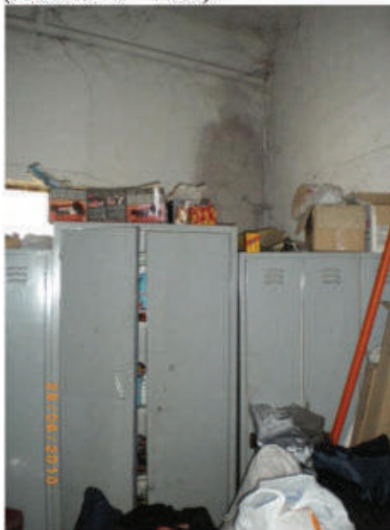
(Foto n. 12 - deposito)
