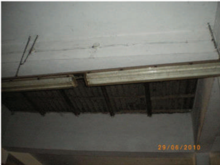
(Foto n. 15 – vano sub 3 del piano primo. Al piano terra non è presente la rampa di scale)
