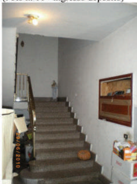
(Foto n. 13 - vano scala sub. 1)
