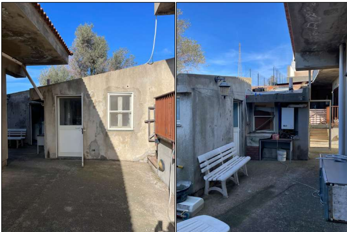
5.1. Vista esterna deposito.
