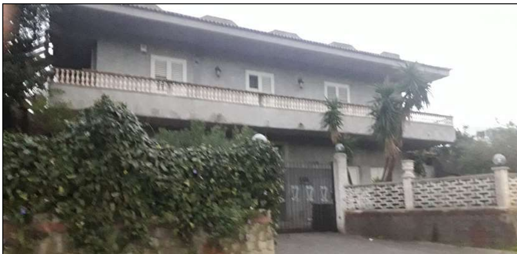
2.1. Vista esterna dell'immobile, ingresso sulla via prioncipale
