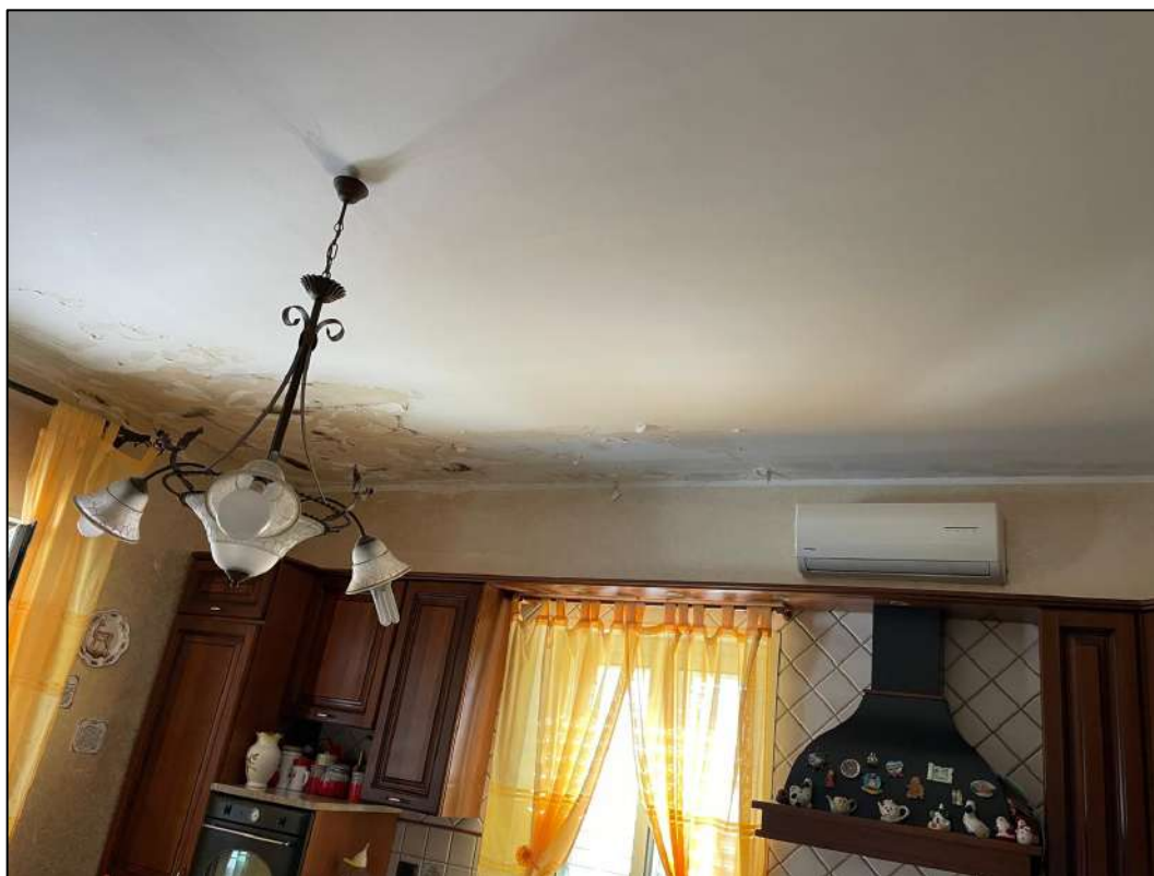
2.3. Vista interna vano Cucina
