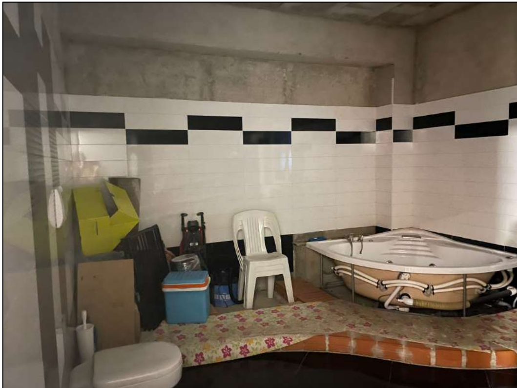
3.6. Vista interna del locale wc
