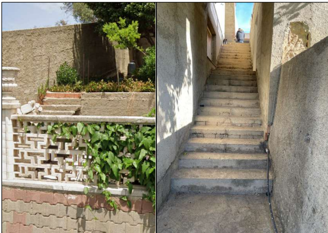
2.14. Vista area esterna scale di accesso dal piano seminterrato al piano terra
