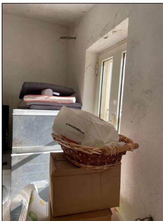
5.2. Vista interna deposito.
