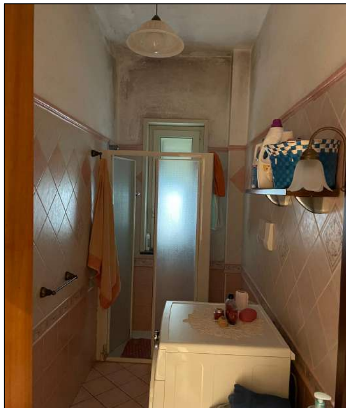
2.5. Vista interna locale wc
