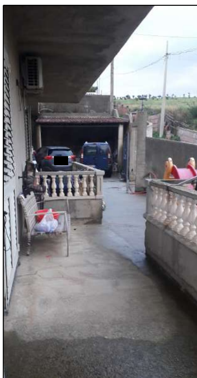
2.15. Vista area esterna piano terra
