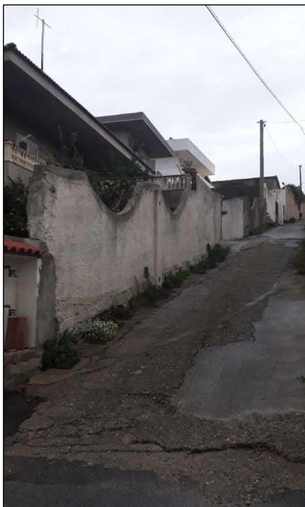
2.2. Vista esterna strada provata di accesso al secondo accesso.
