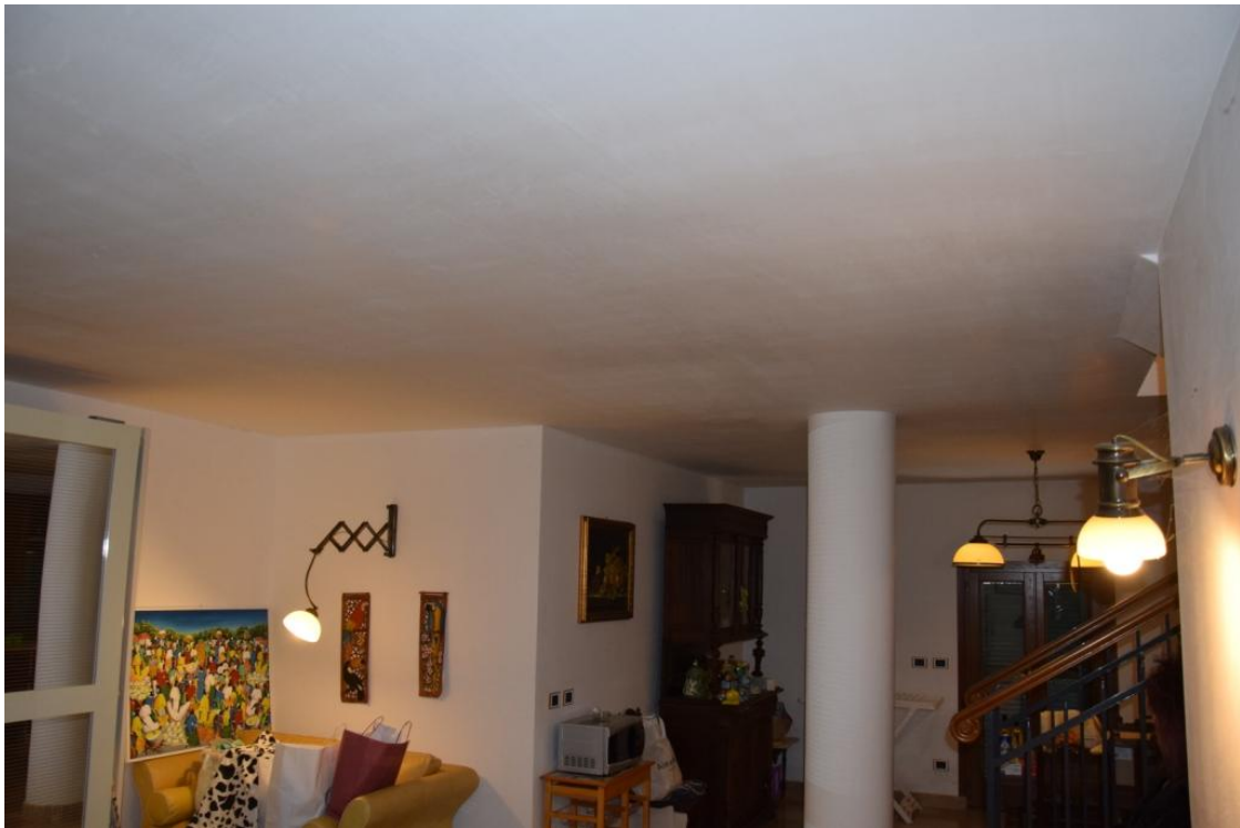
Lotto 4 Foto 10 Interno piano seminterrato (prima abitazione)
