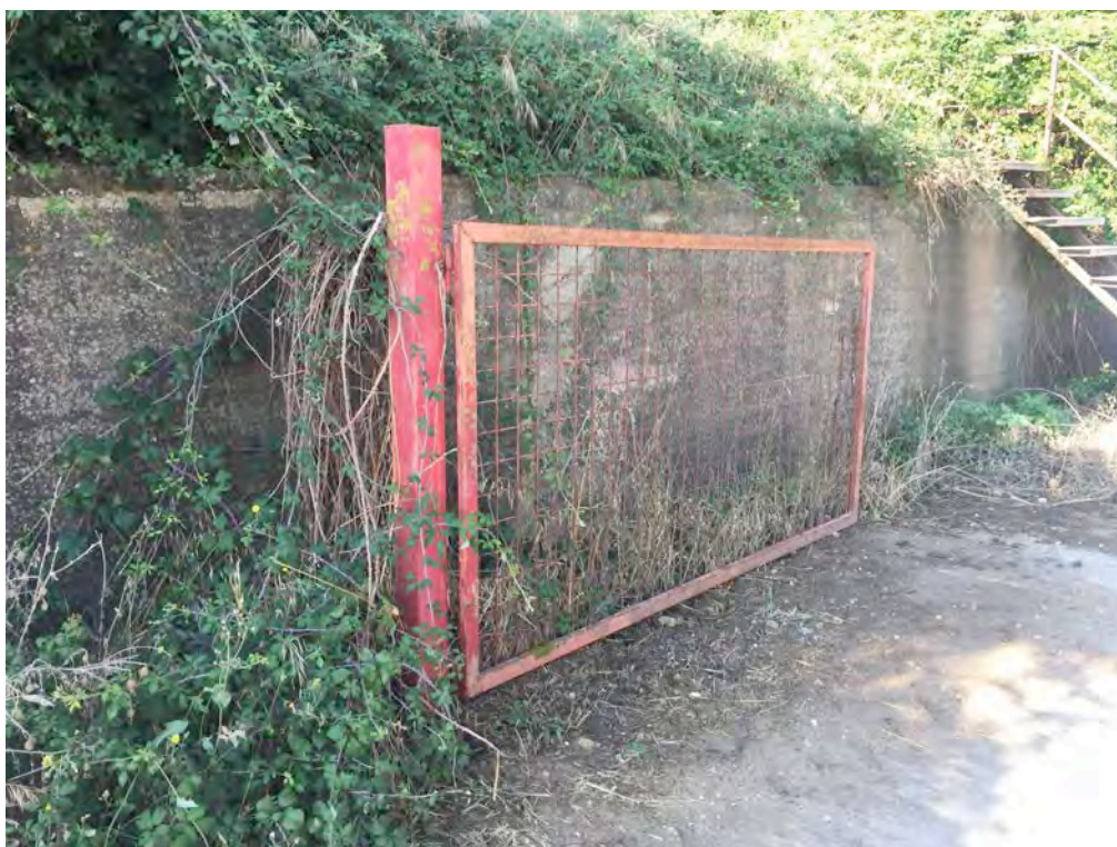
Foto n°4 - Particolare del cancello di accesso
