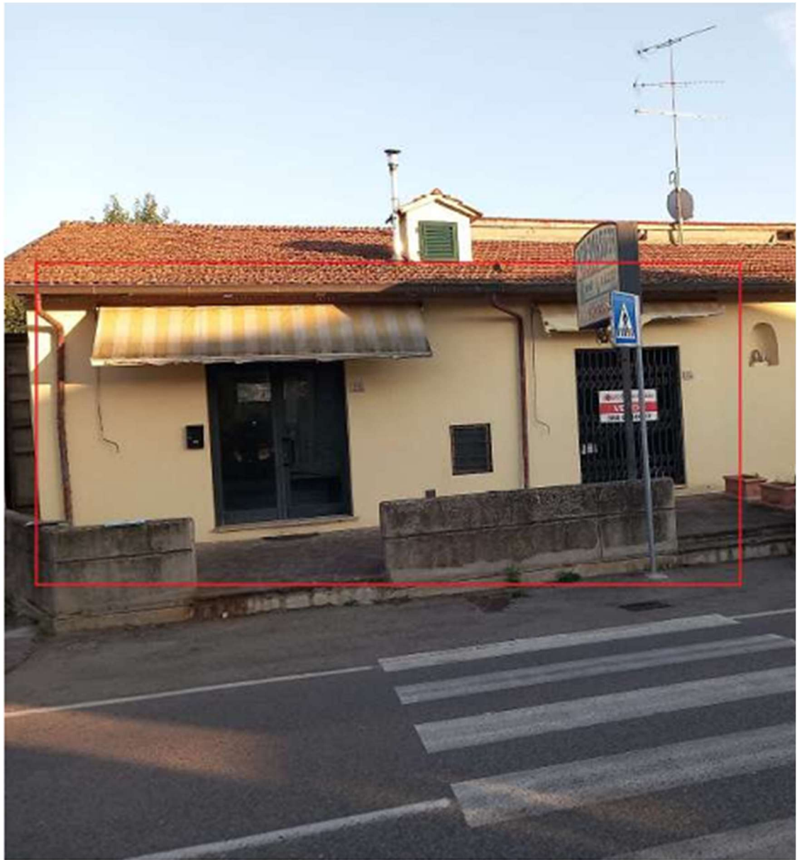
Esterno lato strada
