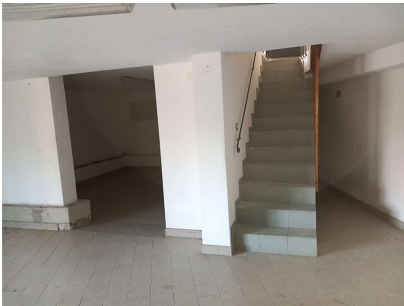
Scale collegamento tra ufficio e magazzino
