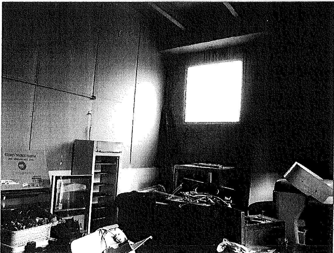
FOTO N° 10 Opificio – Piano Terra – interno
