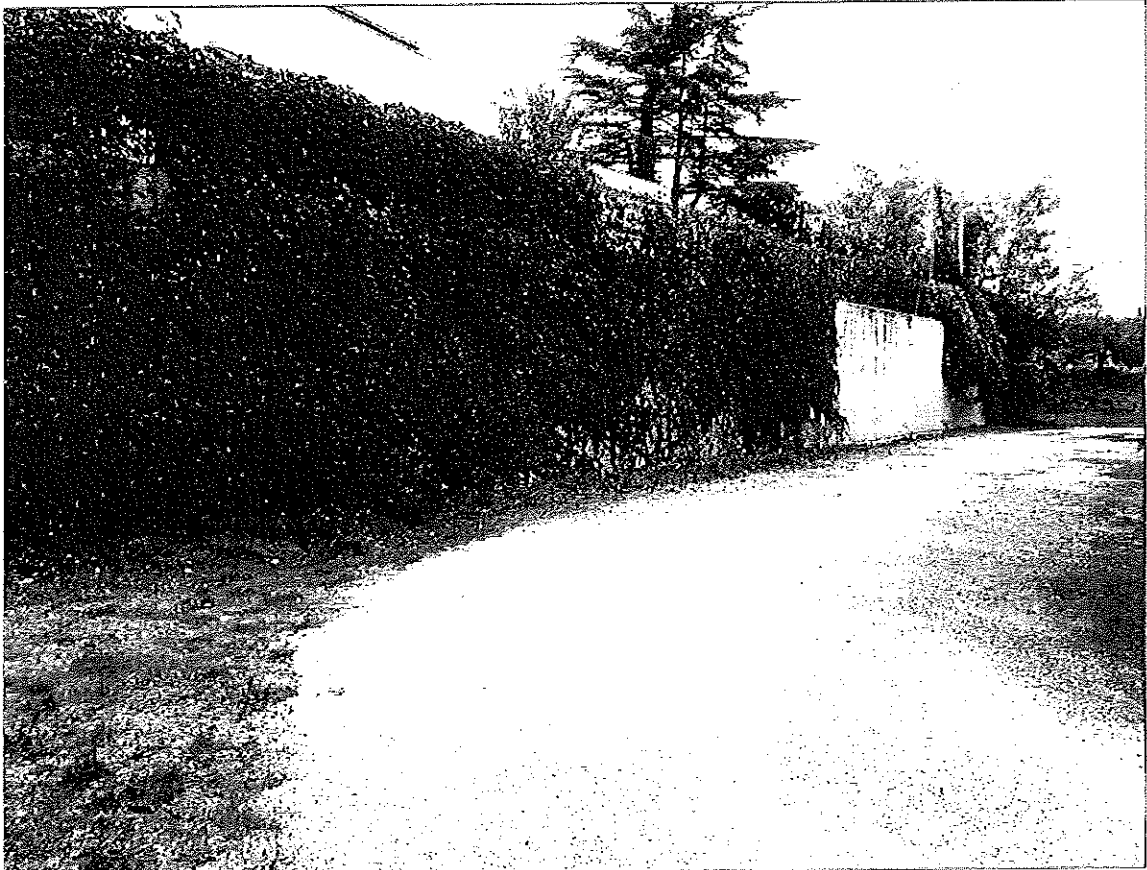
FOTO N° 08 Muro di sostegno foto Ovest
