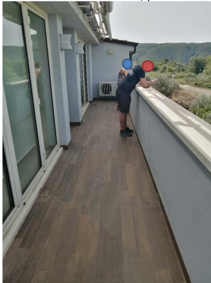
Foto n. 26 – particolare balconata esterna lato ovest Piano 3, “particella n.605 sub.17” - Via Salice –
