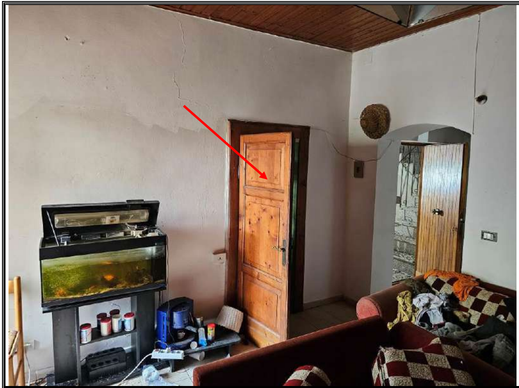
Foto n. 13 Porta di accesso al bagno ubicata nel soggiorno.
