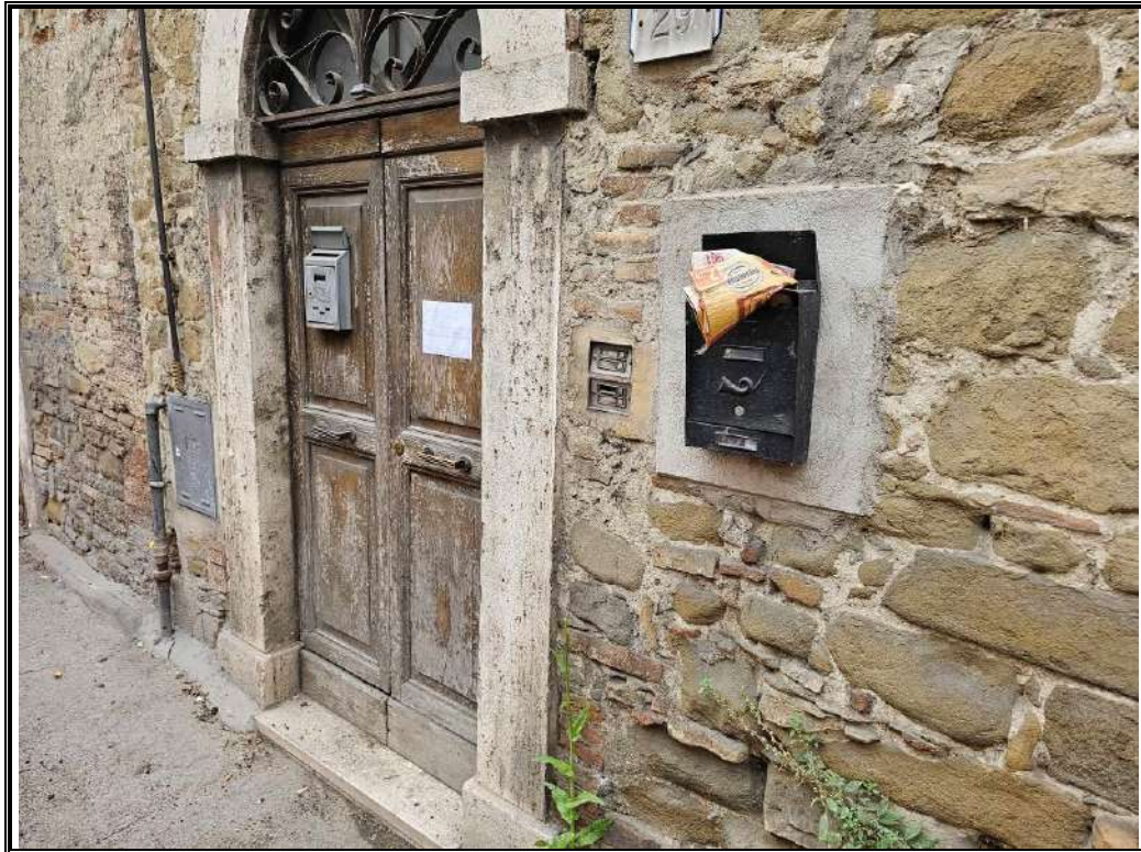
Foto n. 7 Portone di accesso alla palazzina, prospiciente la pubblica via.
