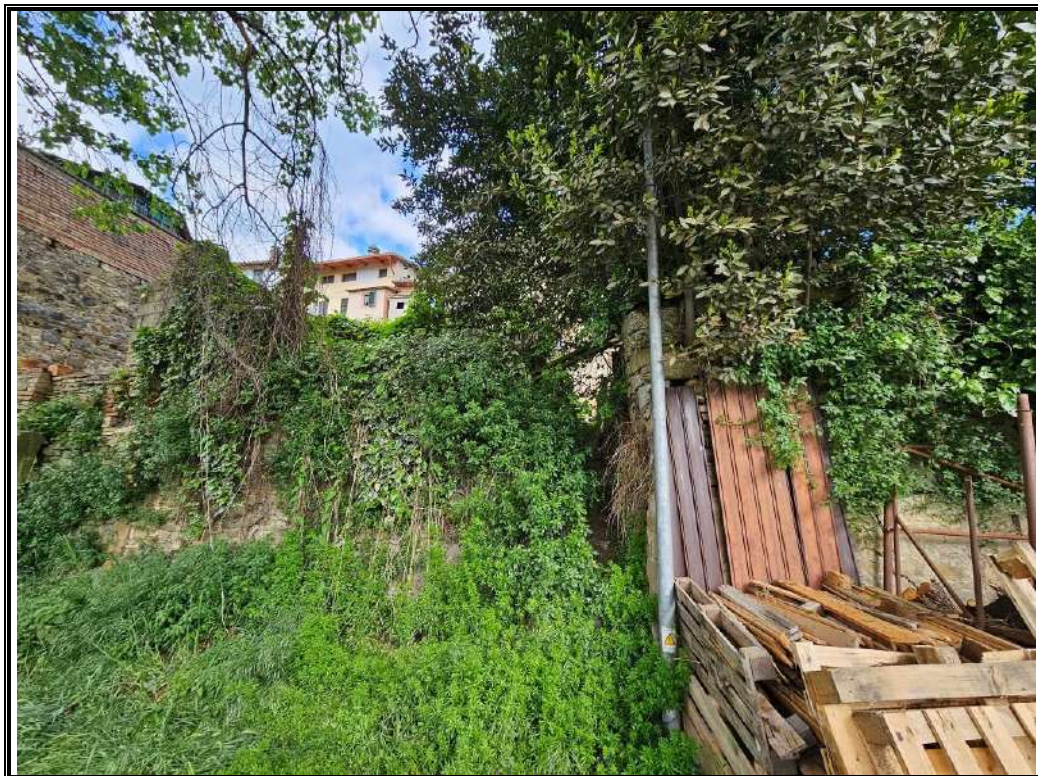
Foto n. 3 Vista dell'accesso alla corte retrostante la palazzina.
