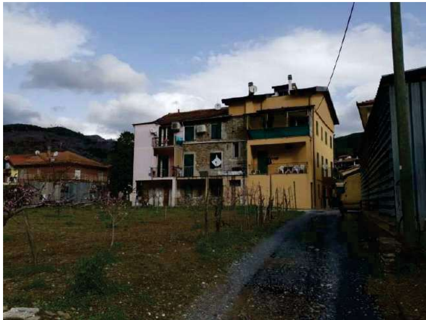
Foto 4 – Vista dell'edificio da retro - Corpo A
