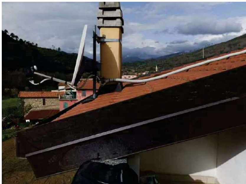
Foto 16 – Vista particolare del tetto dal balcone
