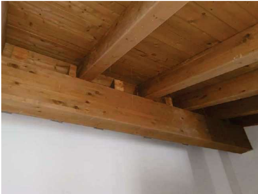
Foto 12 – Vista particolare copertura a tetto
