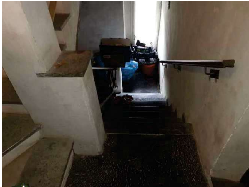
Foto 20 – Vista vano scala
