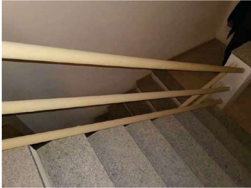
Foto 19 – Vista vano scala
