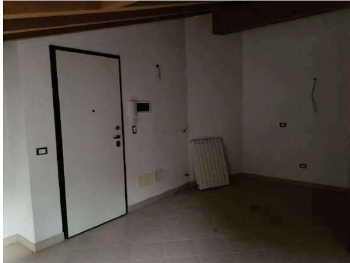
Foto 5 – Vista ingresso – Corpo A
